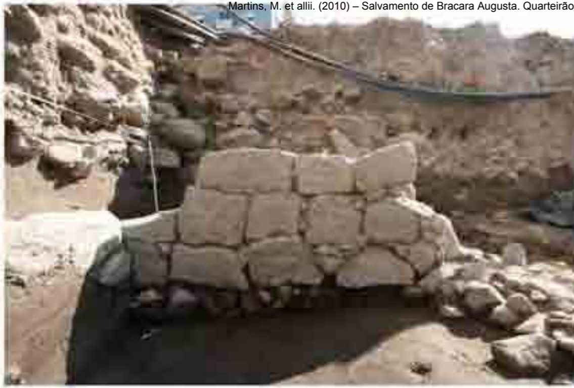
IMG_01926 - Alçado oeste da estrutura UE2029 (O/E)
