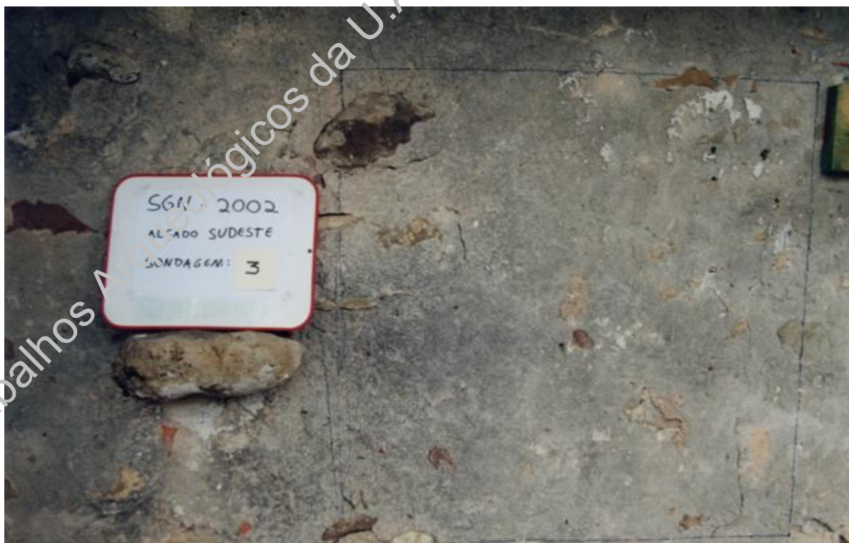
Foto 21 - Alçado SE, sondagem 3, plano 1
