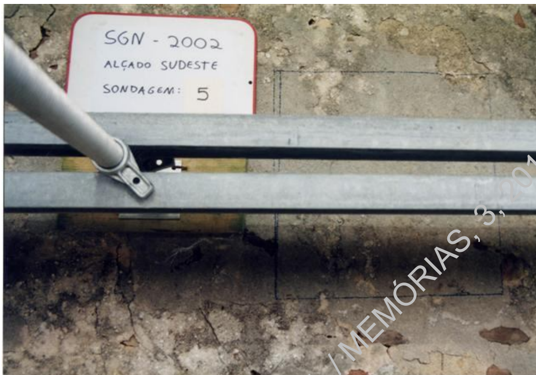
Foto 25 - Alçado SE, sondagem 5, plano 1
