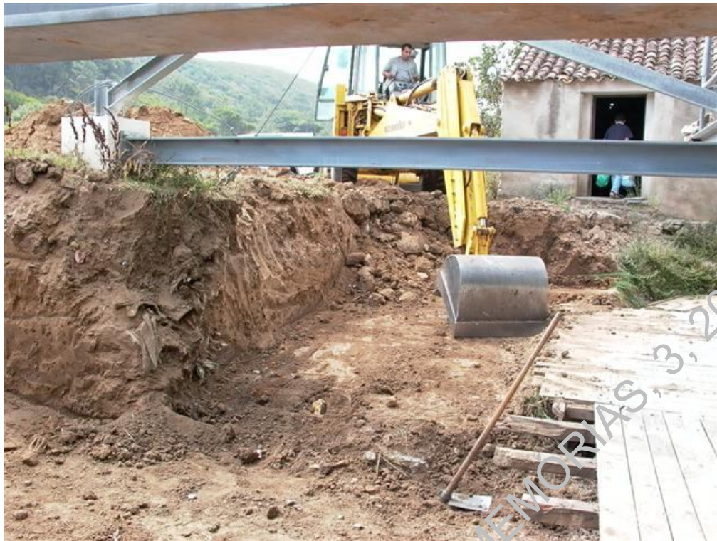
Foto 6 – Fase de desaterro com retroescavadora, na zona a SE da cabeceira
