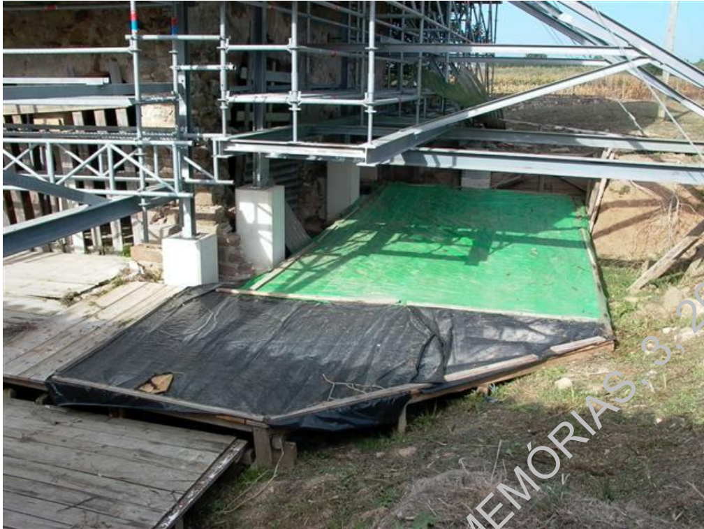
Foto 8 – Perspectiva final da zona da cabeceira, protegida com estrado de madeira e oleado
