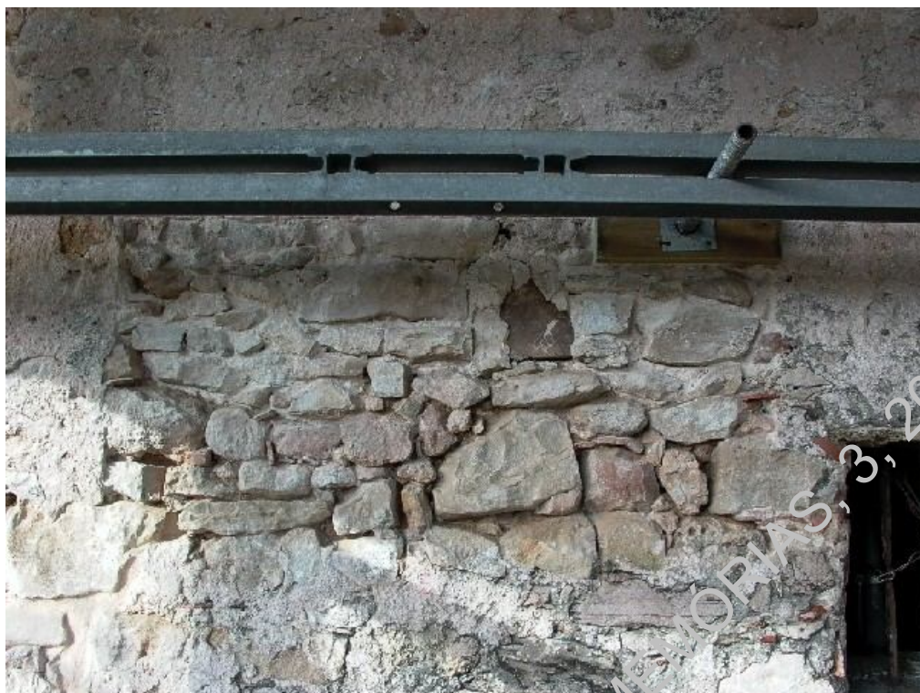
Foto 14 - Alçado NE, sondagem 1, plano final
