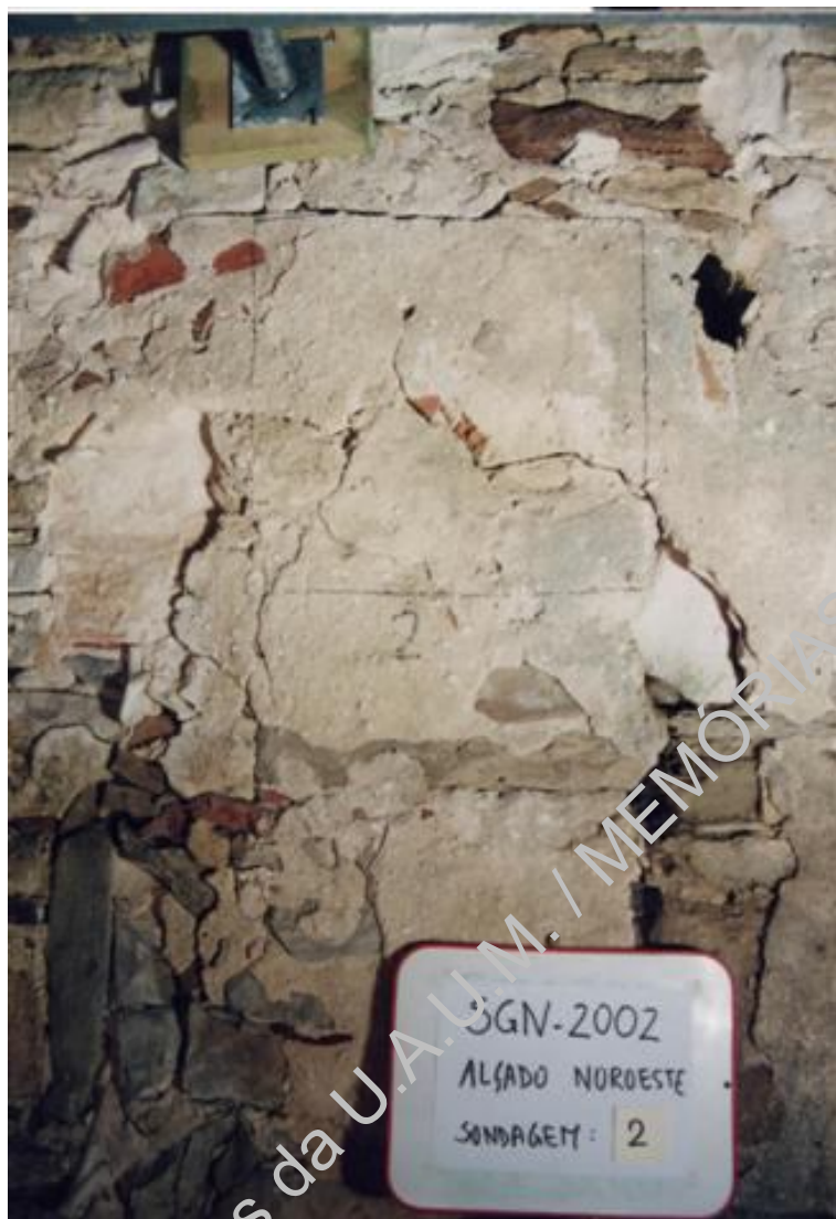
Foto. 11 - Alçado NO, sondagem 2, plano 1
