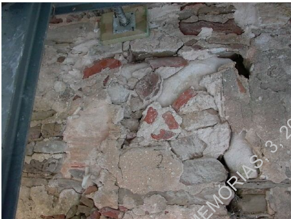
Foto 12 - Alçado NO, sondagem 2, plano final
