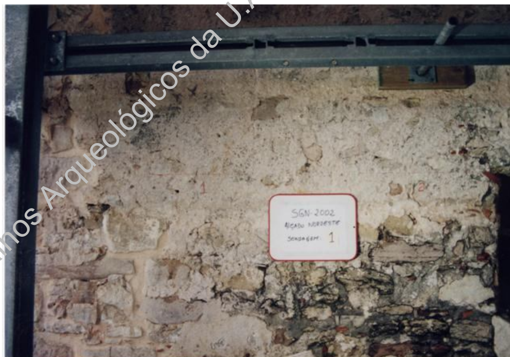
Foto 13 - Alçado NE, sondagem 1, plano 1
