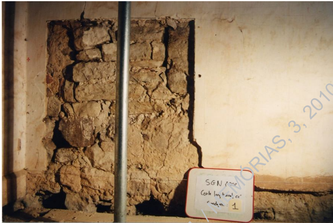
Foto 31 - Corte longitudinal CC', sondagem 1, plano final
