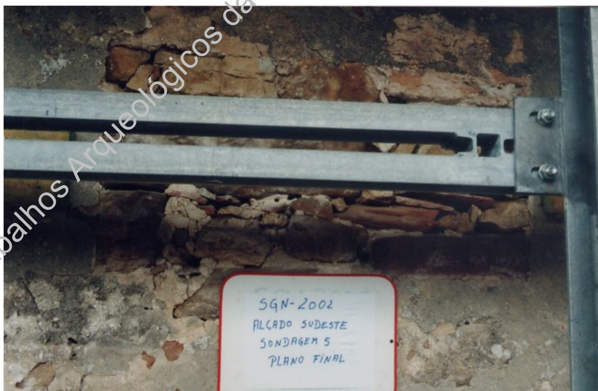
Foto 26 - Alçado SE, sondagem 5, plano 1
