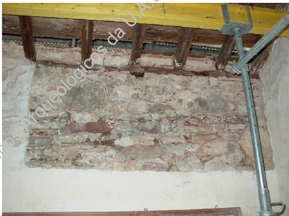
Foto 28 - Corte longitudinal BB', sondagem 1, plano final
