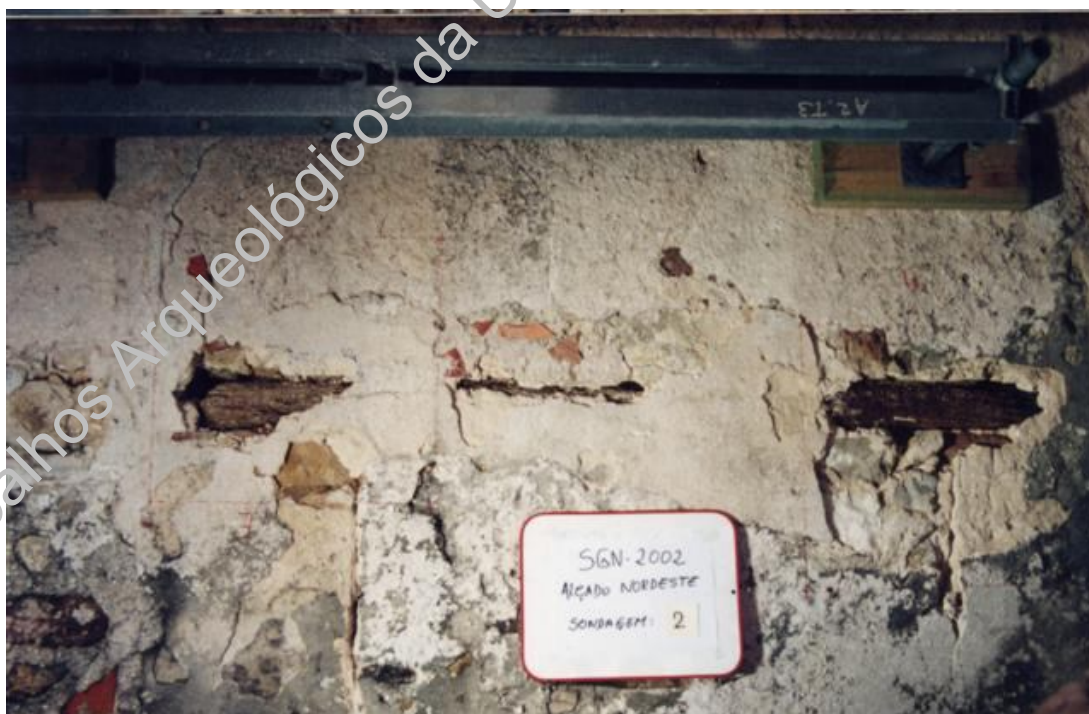
Foto 15 - Alçado NE, sondagem 2, plano 1
