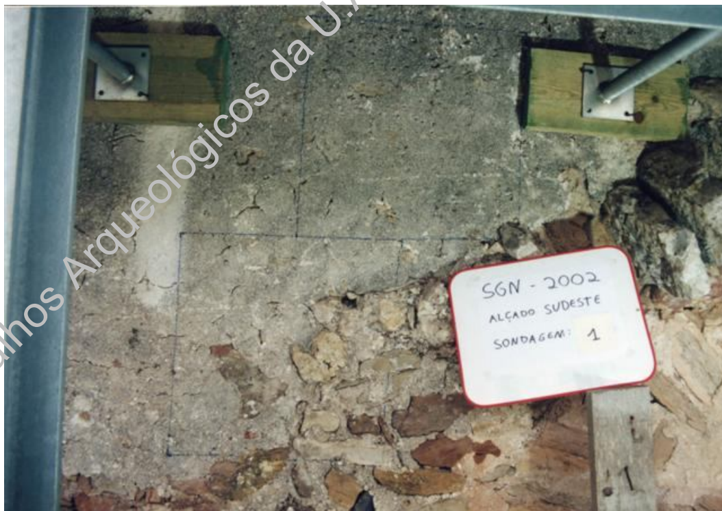
Foto 17 - Alçado SE, sondagem 1, plano 1
