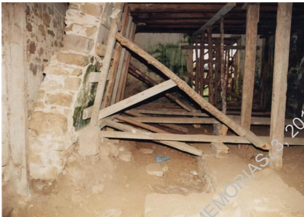
Foto 43 - Ala NE, ainda com parede de suporte do piso superior
