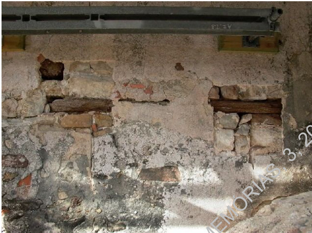
Foto 16 - Alçado NE, sondagem 2, plano final
