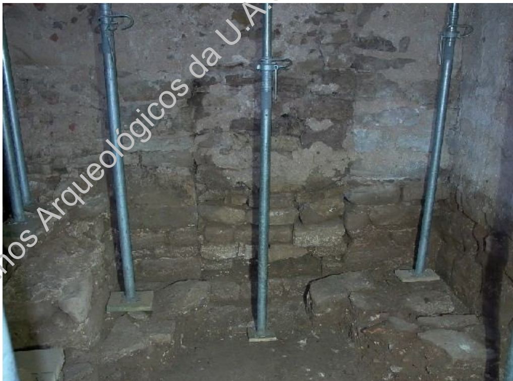
Foto 49 - Quadrícula x104-108 / y102,5-105, plano final, pormenor da porta de comunicação com nave
