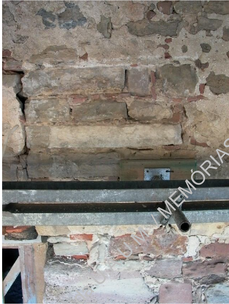
Foto 10 - Alçado NO, sondagem 1, plano final
