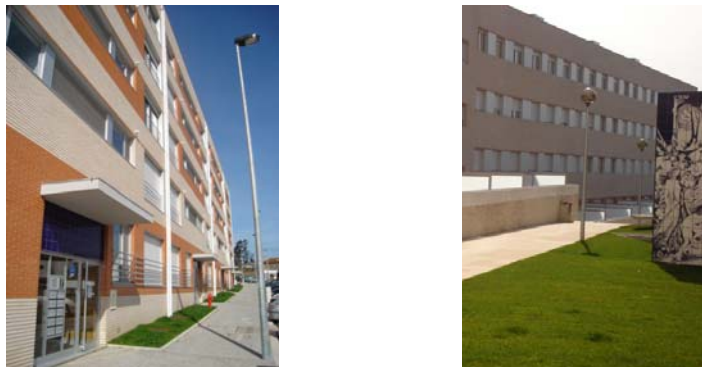
Figura 3.17 - Fotografias das fachadas, principal, a Sudeste e posterior, a Noroeste, do Edifício 1
