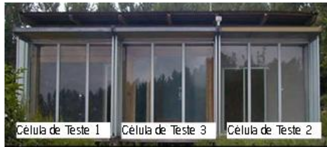
Figura 3.2 - Vista do alçado Sul das Células de Teste de Edifícios não Convencionais
