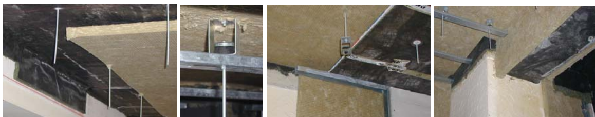
Figura 5.99 - Pormenores do processo de reabilitação acústica
