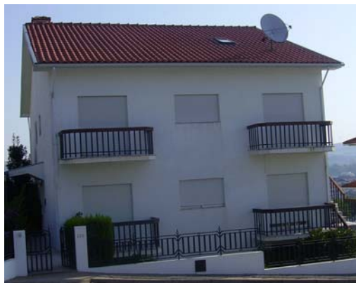
Figura 3.26 - Alçado principal do Edifício 8
