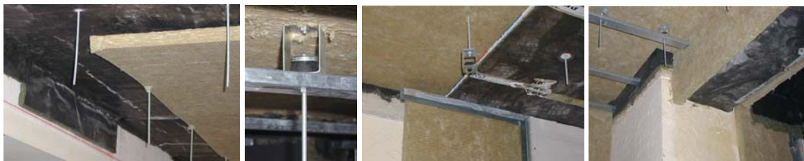
Figura IV.206 – Pormenores do processo de reabilitação acústica
