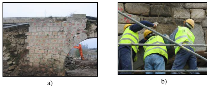
Fig. 4.15 – Reconstrução de elementos estruturais: a) numeração e desmonte das pedras; b) reconstrução do muro (Ponte Dom Zameiro, EP 2008)
