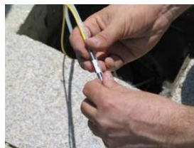
Fig. 2.47 – Aplicação de um sensor de temperatura (FiberSensing)
