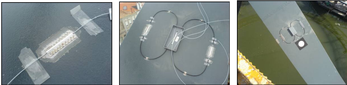
Fig. 2.50 – Aplicação de sensores de fibra óptica em estruturas metálicas (FiberSensing)
