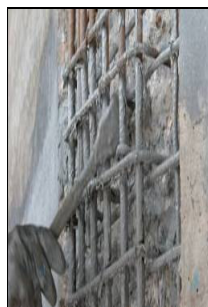
Fig. 4.4 – Reparação do betão e reforço das armaduras (Ponte da Barra, EP 2007)
