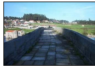
Fig. 5.42 – Vista sobre a Ponte, lajeado de granito
