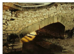
Fig. 3.30 – Mecanismo de rotura devido a uma carga pontual excessiva e assimétrica
