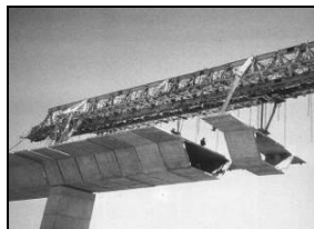
Cimbra móvel autoportante superior
