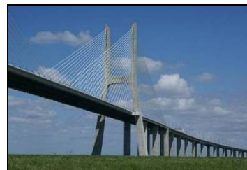
Fig. 2.11 – Ponte Vasco da Gama
