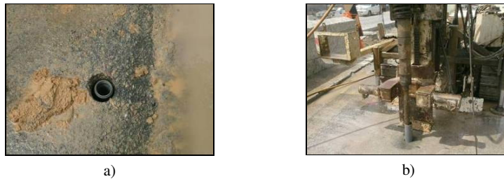
Fig. 4.13 – Reforço do enchimento do encontro: a) furo: b) execução da injeção por gravidade (Ponte Meinedo, EP 2009)
