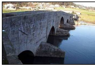
Fig. 5.41 – Vista montante da Ponte
