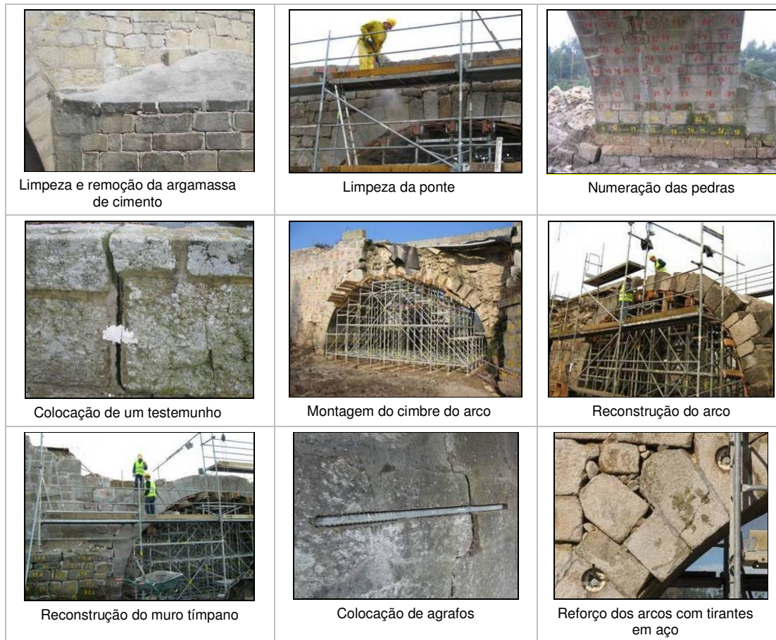
Fig. 5.46 – Trabalhos de reabilitação e reforço realizados na Ponte Dom Zameiro.
