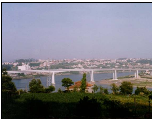
Fig. 2.5 – Exemplo de uma ponte em pórtico: Ponte do Freixo
