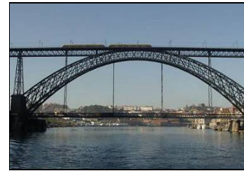
Fig. 2.9 – Ponte em ferro: Ponte Luíz I
