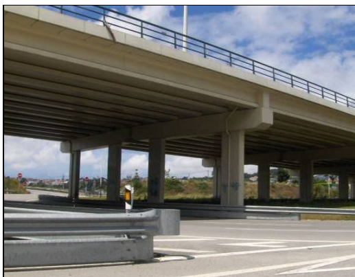
Fig. 2.3 – Exemplo de uma ponte em Viga simplesmente apoiada: Viaduto das Areias (EP 2007)
