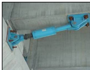
Fig. 4.20 – Dispositivo passivo de dissipação de energia.
