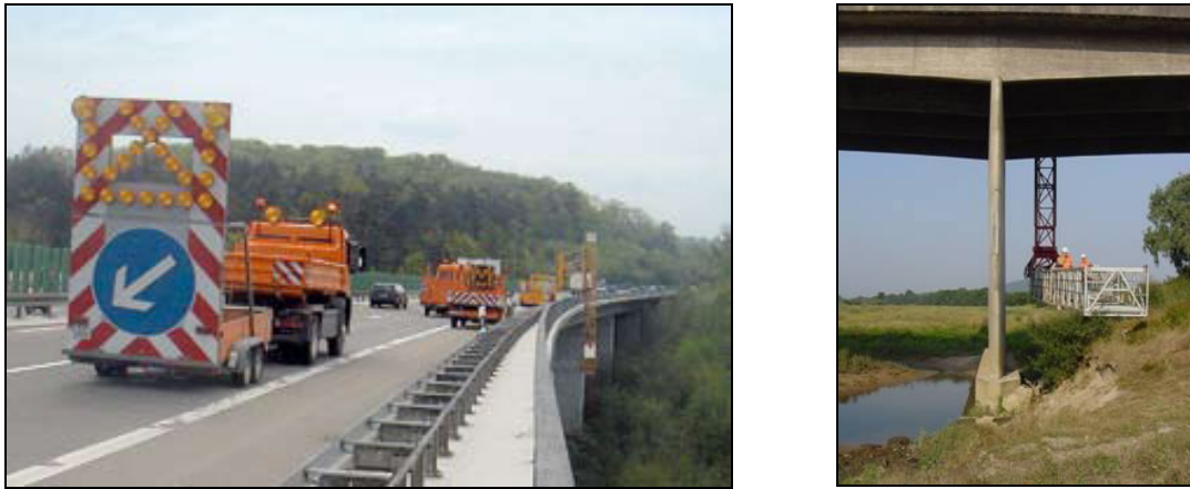
Fig. 2.39 – Inspeções principais realizadas com recurso a plataforma
