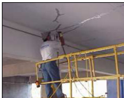
Fig. 4.6 – Injecção de fendas com resina epoxy (Rodrigues 2005).
