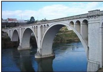
Fig. 2.7 – Ponte de Alvenaria de Pedra: Ponte Duarte Pacheco
