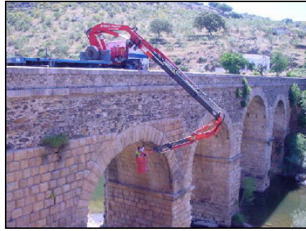
Fig. 2.40 – Equipamento de inspeção de pontes (EP 2006)
