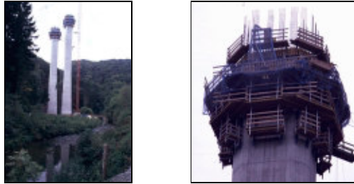
Fig. 2.23 – Construção de um pilar, Pont sur la Mentue
