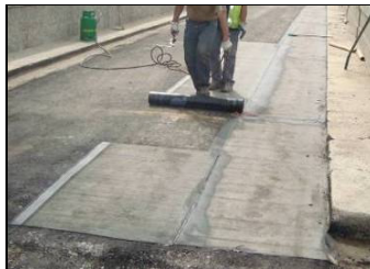
Fig. 4.14 – Impermeabilização do tabuleiro (Ponte Meinedo, EP 2009)
