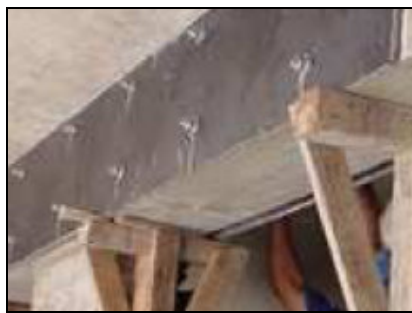
Fig. 4.7 – Pormenor de colocação de buchas e chapas metálicas (Rodrigues 2005).
