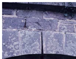
Fig. 3.29 – Mecanismo de rotura devido a uma carga pontual central
