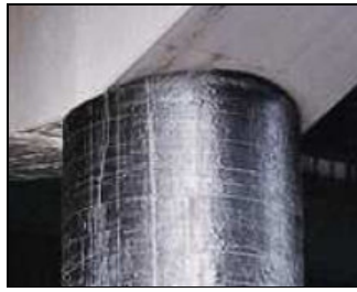
Fig. 4.8 – Reforço de pilares com CRP
