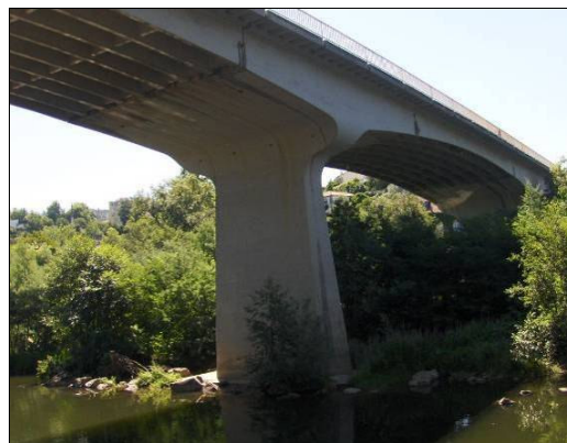
Fig. 2.4 – Exemplo de uma ponte em Viga Gerber: Ponte de Amarante (EP 2007)
