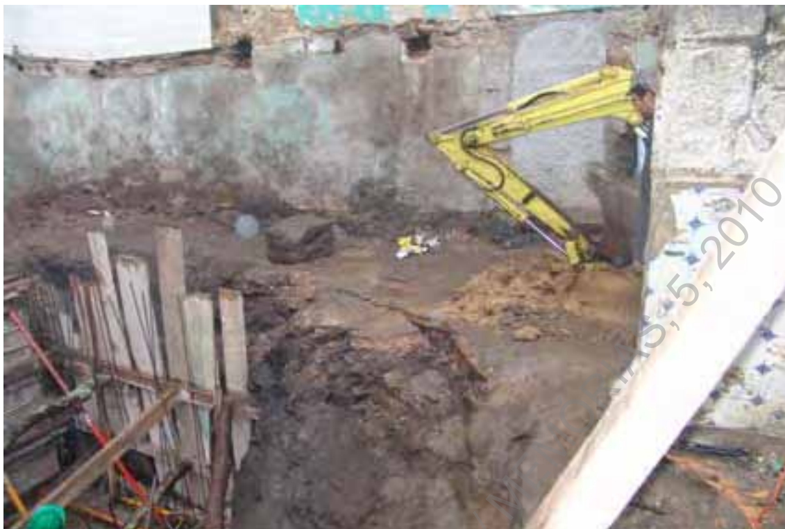
Foto 119 (D 380) Desaterro Mecânico – acompanhamento (plataforma Sul).
