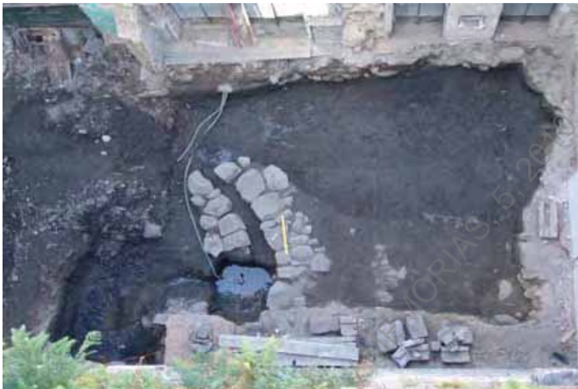
Foto 7 (D 193), Levantamento inicial (Vista torre), orientação SE/NO.
