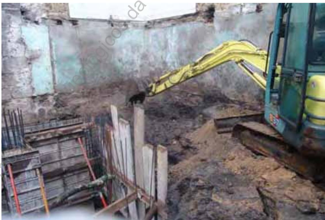
Foto 120 (D 381) Desaterro mecânico – acompanhamento (plataforma Sul).
