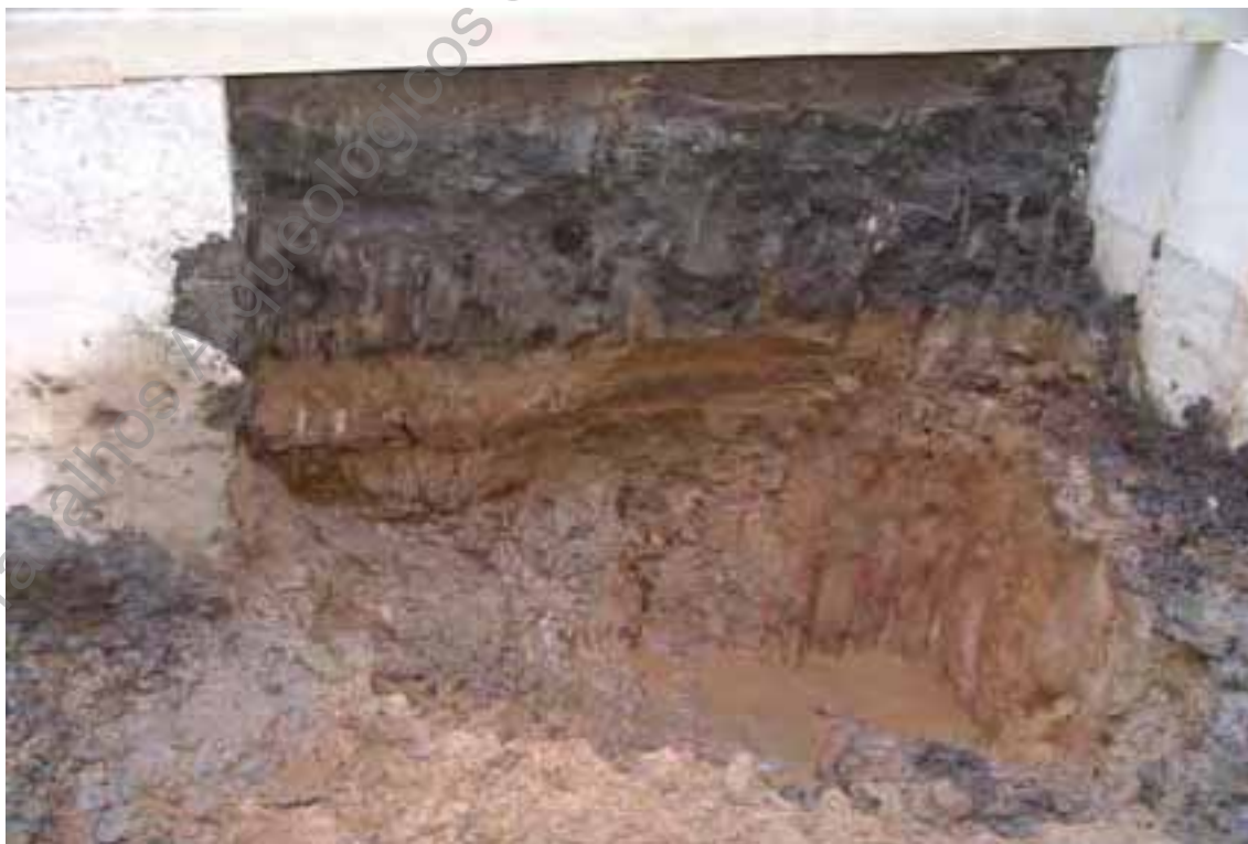
Foto 112 (D 330) Desaterro mecânico – acompanhamento (área norte).
