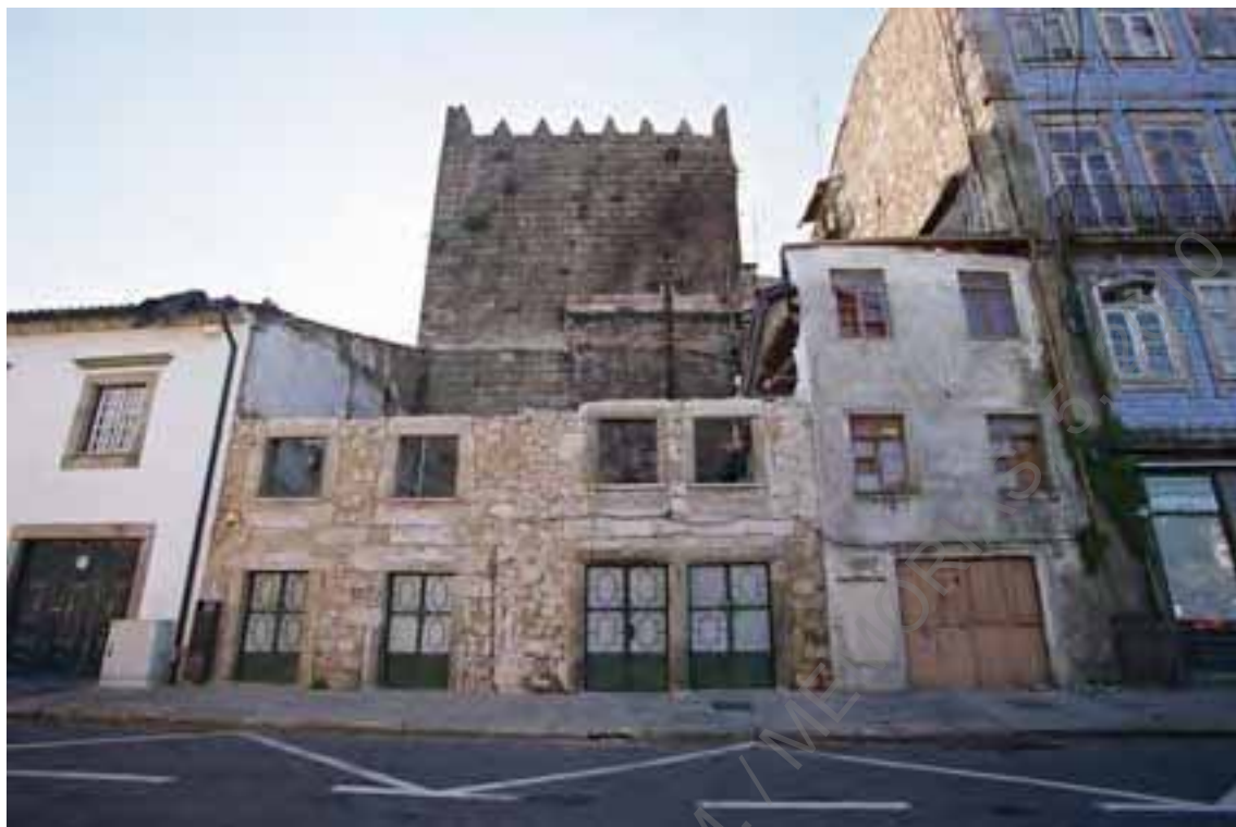
Foto 1 (A4/07): Fachada exterior 89-97.
