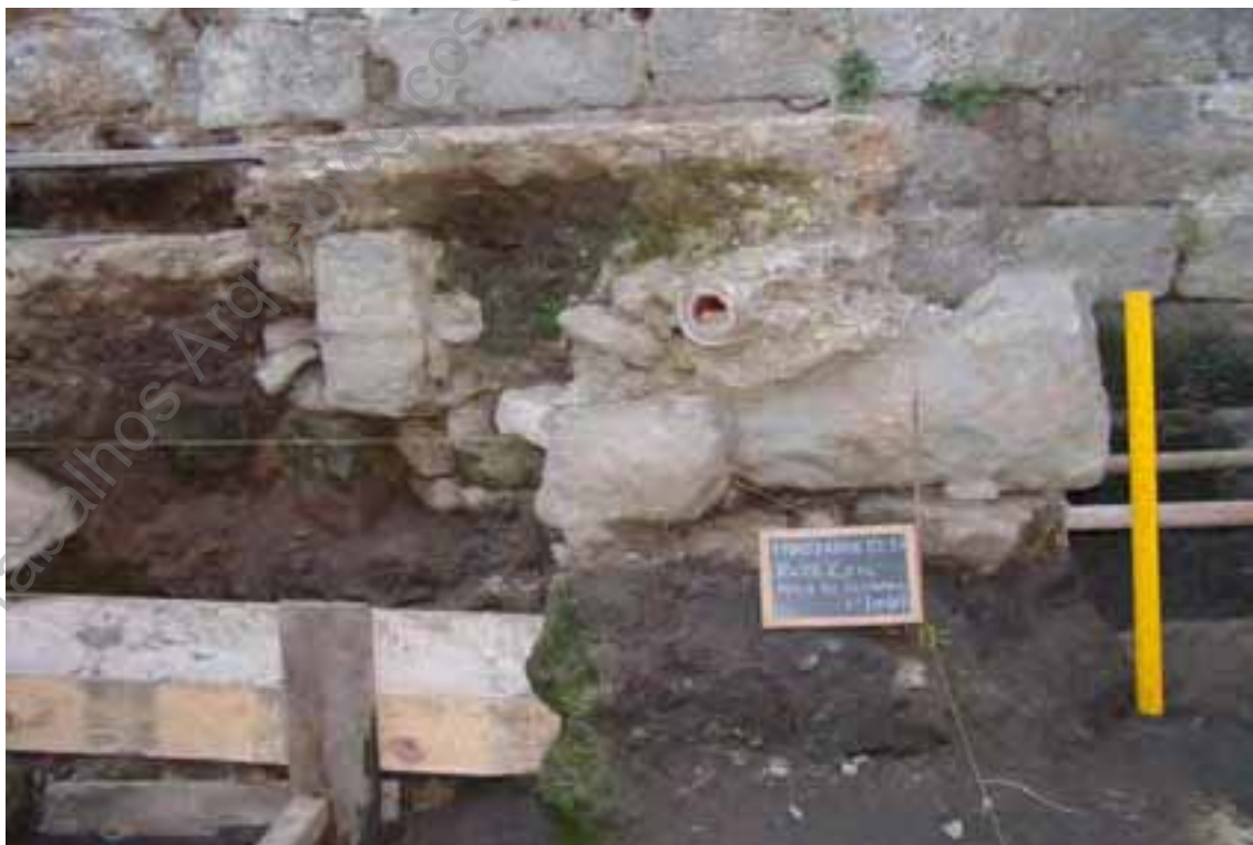
Foto 110 (D 253) Perfil Este (Testemunho), após escavação manual das sondagens (Parte II)
