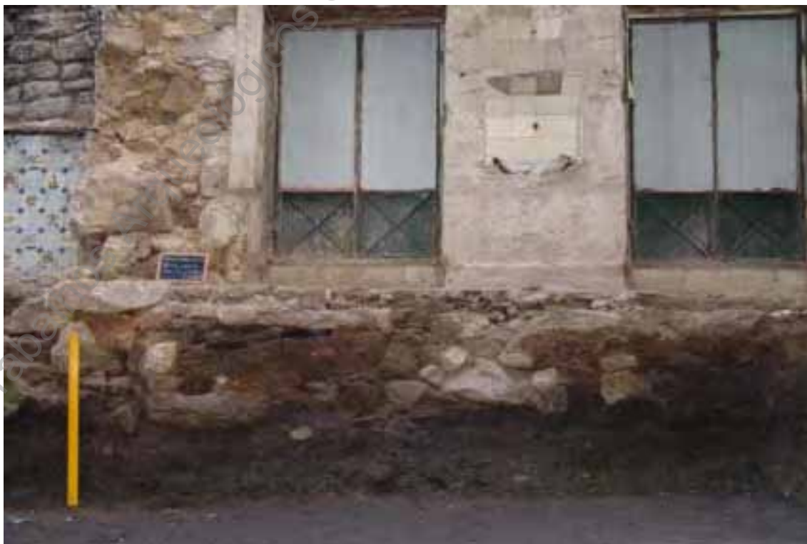
Foto 108 (D 255) Perfil Oeste, após escavação manual das sondagens (Parte II)
