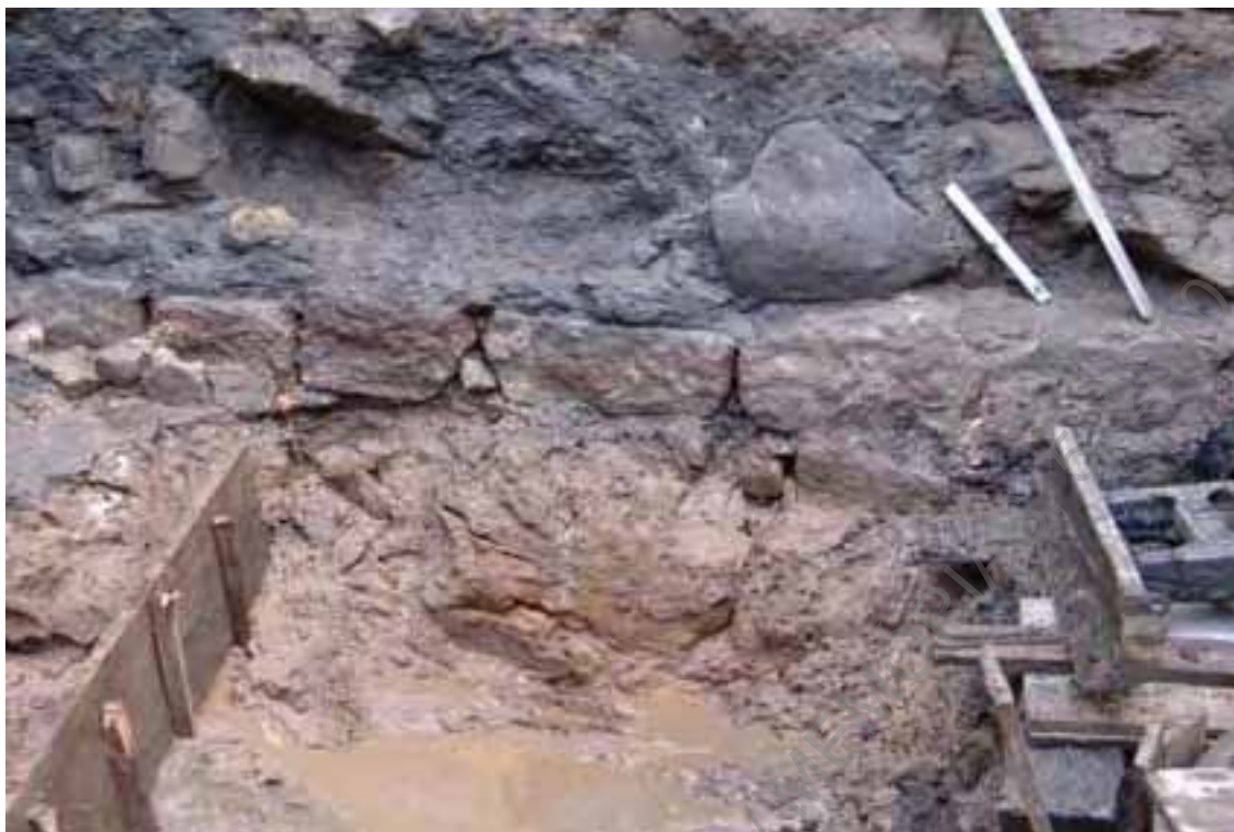
Foto 115 (D 374) Desaterro mecânico – acompanhamento (Pormenor do =300= e =303=).
