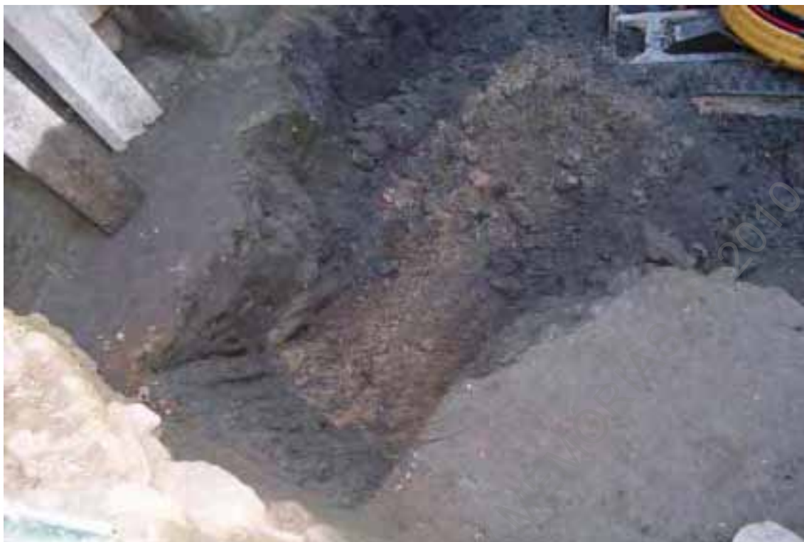
Foto 111 (D 290) Desaterro mecânico – acompanhamento (área norte).
