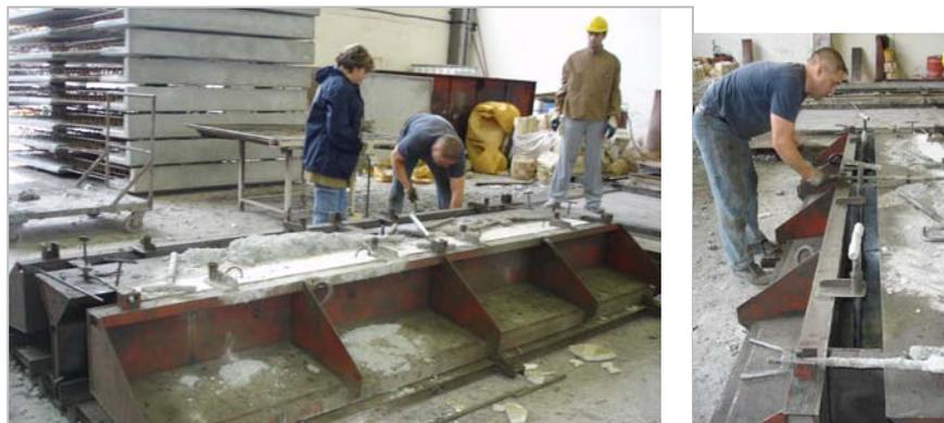
Figura 5.16 – Preparação da cofragem da peça a betonar
