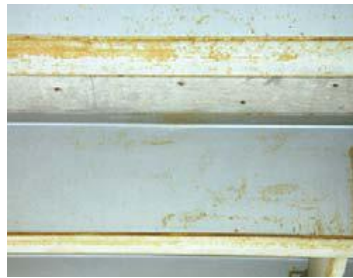
Nível de conservação 2
