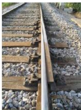
Figura A.2-5 - Junta de dilatação de carril (Fonte: Ribeiro, Diogo, 2004)
