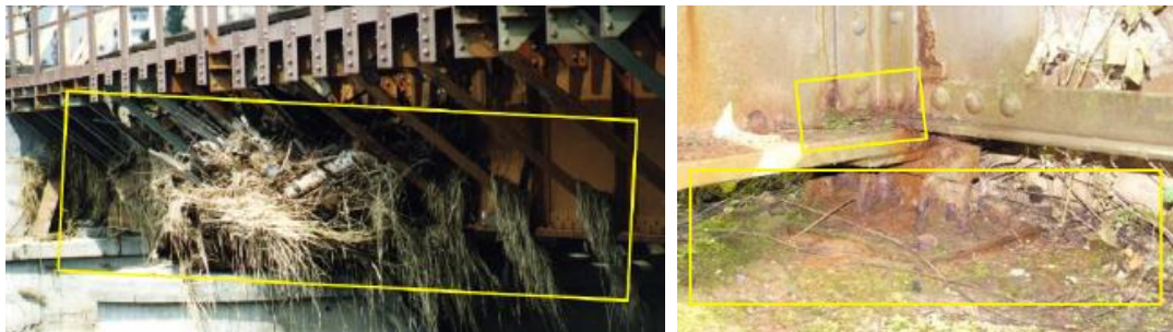
Figura A.3-4 – Degradação por deposição de detritos e ataque microbiano (Sustainable bridges, 2004)
