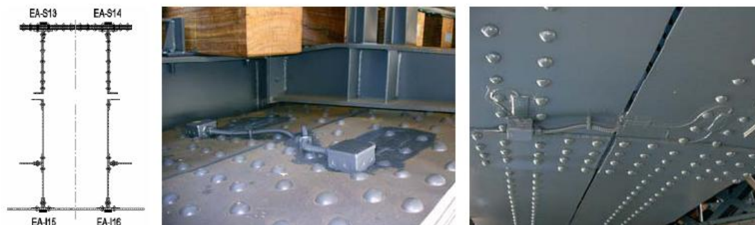
Figura 5-15 – Sensores de deformação no arco da Ponte Luiz I (Costa, B., Félix, C., Figueiras, J. 2006)
