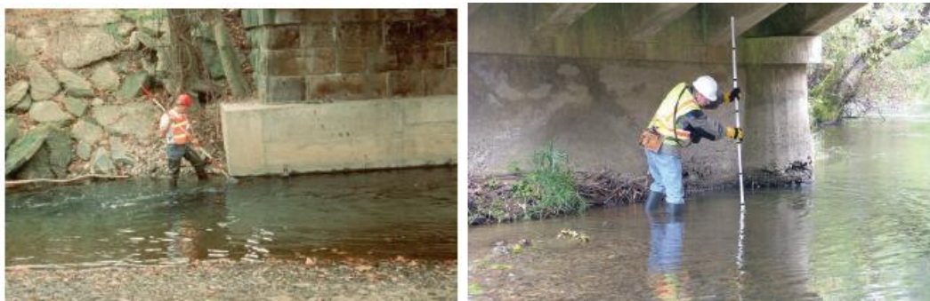
Figura 5-13 – Inspeções subaquáticas em estações secas
