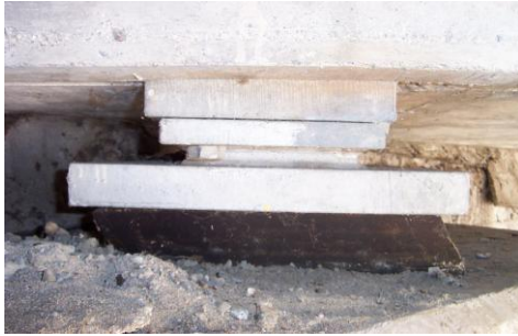
Aparelho de apoio em neoprene
