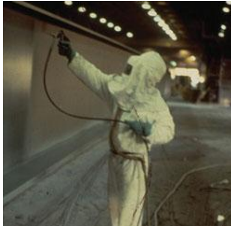
Figura A.4-7 - Preparação em fábrica – aplicação de sistema de protecção (pintura)
