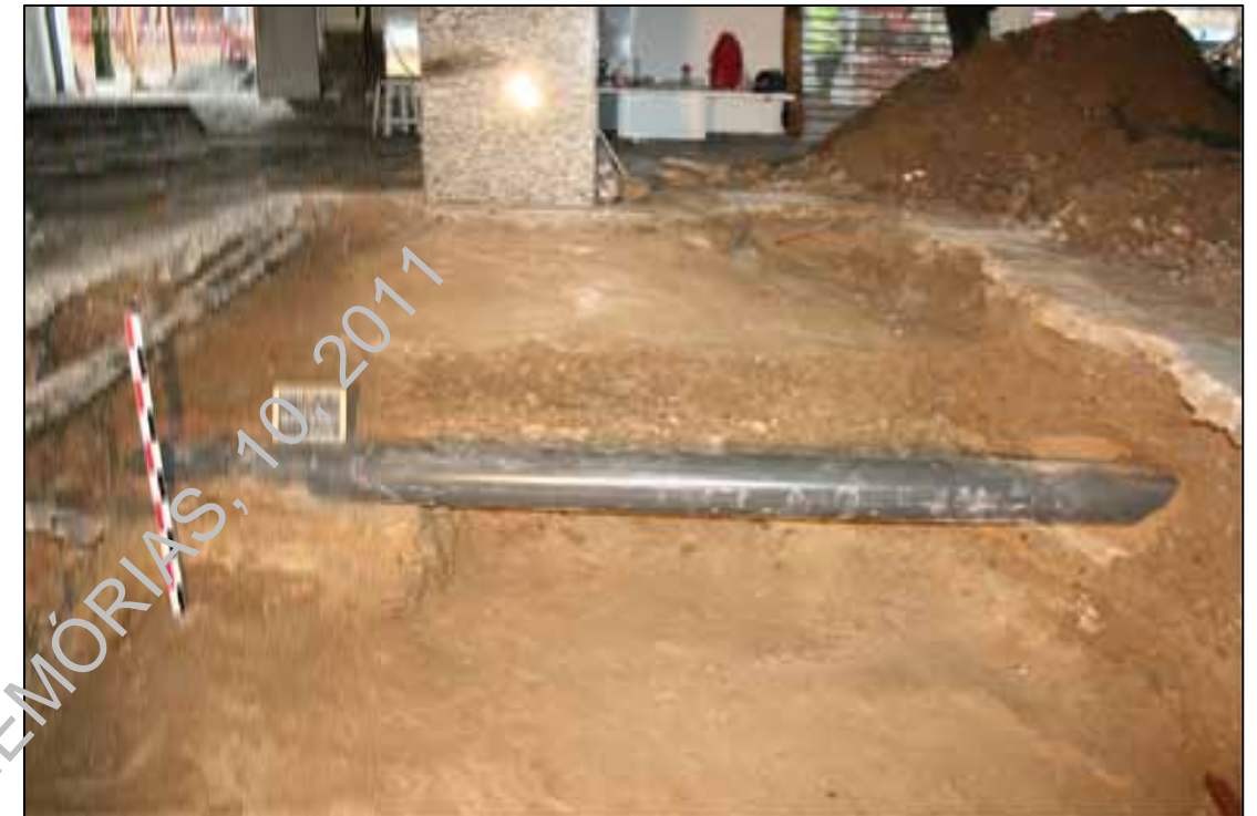
IMG_8254 - Vista geral do perfil este - Sondagem 2 (O/E).
