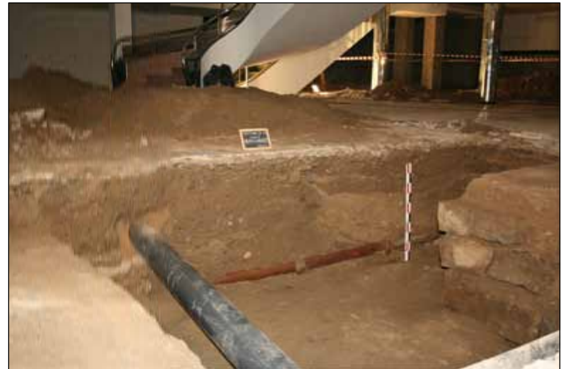
IMG_8244 - Perspectiva geral do perfil sul - Sondagem 2 (NE/SO).
