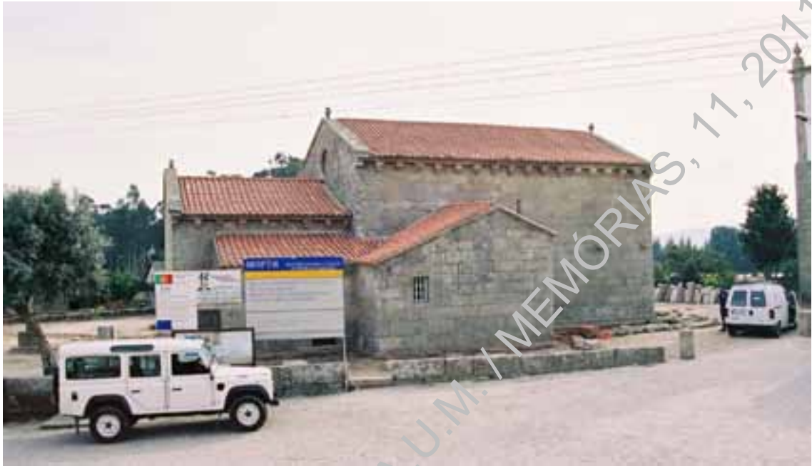
Foto 4 – Vista Norte da igreja e adro
