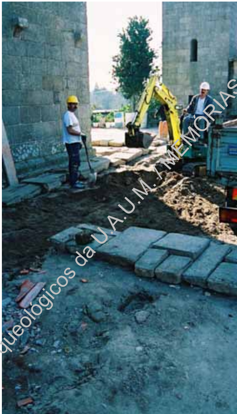
Foto 29 – Vista dos trabalhos de remoção do piso actual, no lado Norte da igreja
