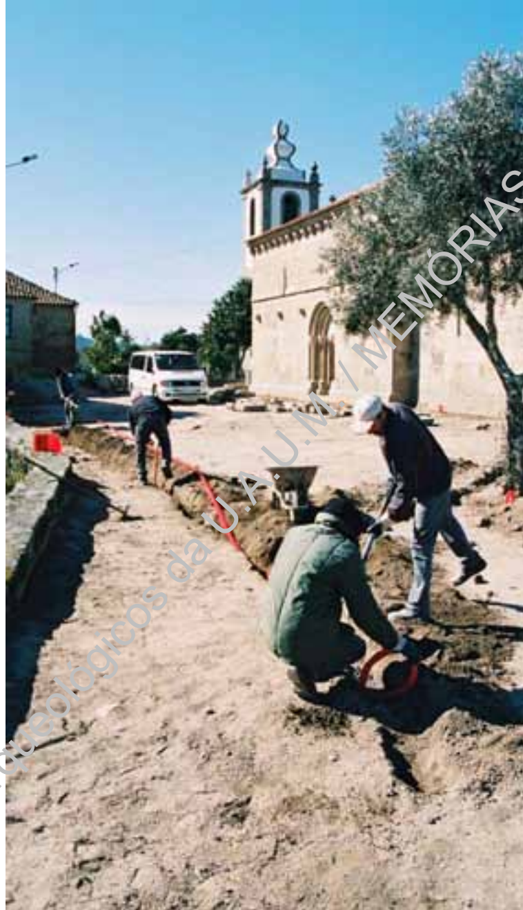
Foto 30 – Vista dos trabalhos de implantação do tubo para iluminação
