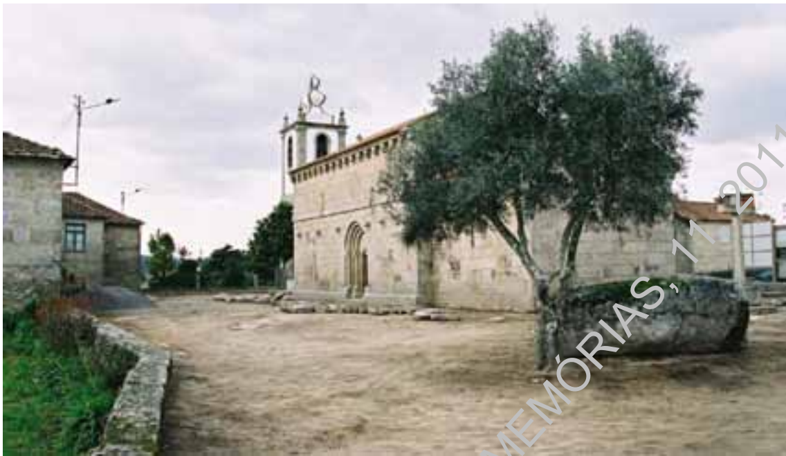
Foto 2 – Vista Sul da igreja e adro
