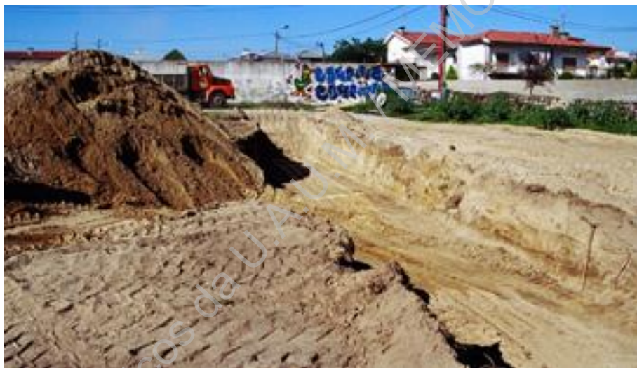
Foto 23 – Fase intermédia do desaterro, vista de Sul.
