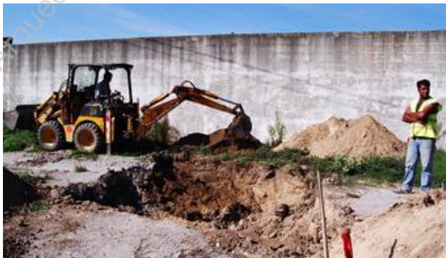
Foto 3 – Início do desaterro com meios mecânicos, no Quadrado C.258.
