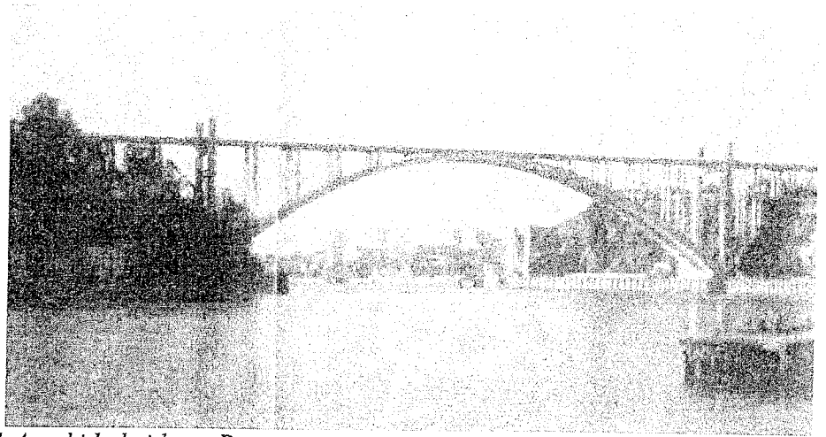
Fig. 1 Arrabida bridge – Porto.
