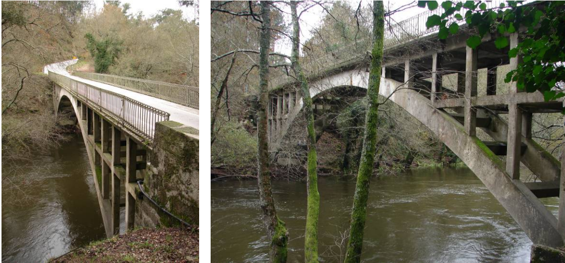
Figura 1. Aspecto da ponte Luiz Bandeira.
