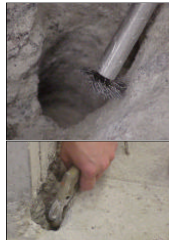
Figura 19 – Limpeza dos buracos de fixação dos laminados à sapata.
