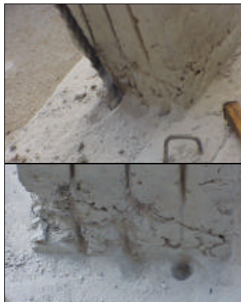
Figura 18 – Abertura dos buracos de fixação dos laminados à sapata.
