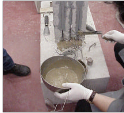
Figura 21 - Aplicação da argamassa epóxida nos buracos de fixação dos laminados à sapata.
