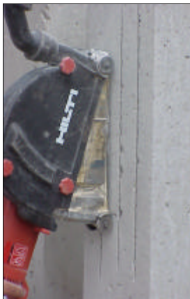
Figura 17 - Abertura das ranhuras.
