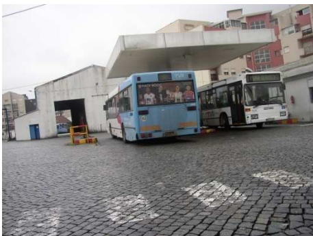
Fotografia n° 6 - Garagem da TUB
