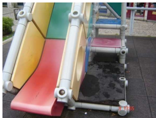
Fotografia nº 11 - Subida do escorrega rompida
