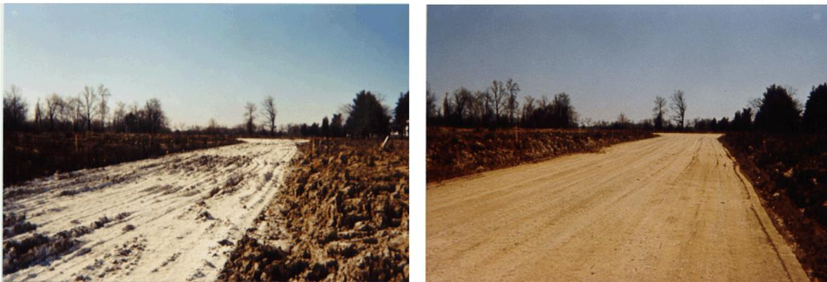
Figura 4.13: Estabilização do solo de fundação de um pavimento rodoviário
