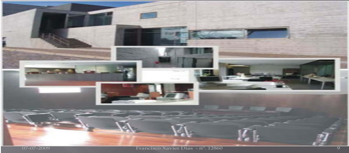
Anexo 2 – Edifício da Sede da AGERE-EM
