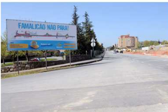
Obras na Avenida do Brasil obrigam a alterações ao trânsito
