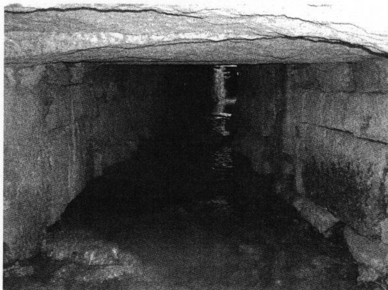
Figura 4 – Troço canalizado da Ribeira
