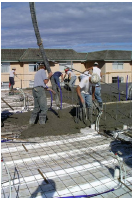
Figura 2.19 - Colocação e Compactação [41]
