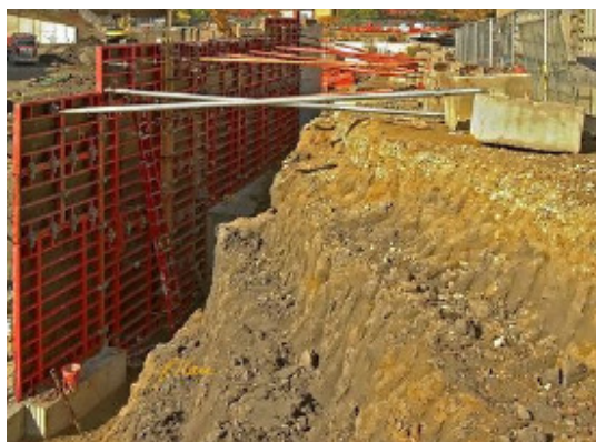
Figura 2.23 - Cofragem metálica de paredes e muros [41]
