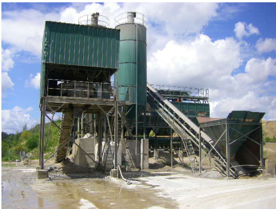
Figura 2.17 - Central de betão
