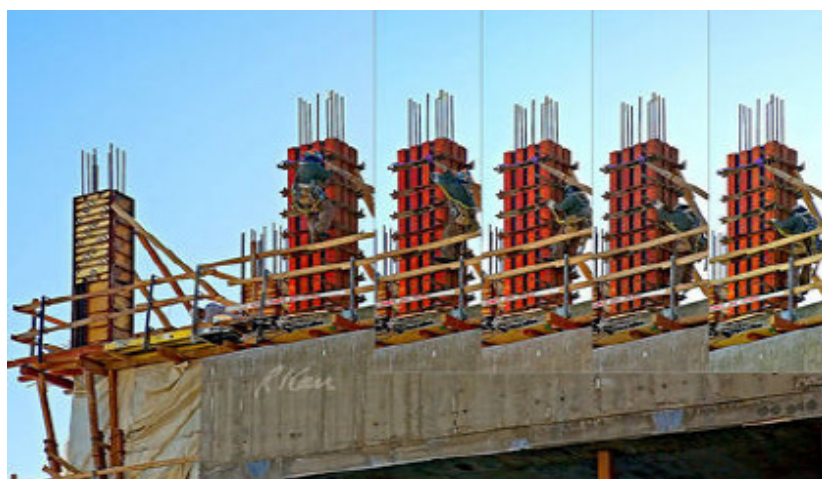
Figura 2.24 - Cofragem metálica de pilares [41]
