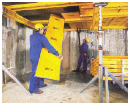
Figura 2.21 - Desmontagem de cimbrês e cofragem de laje [41]
