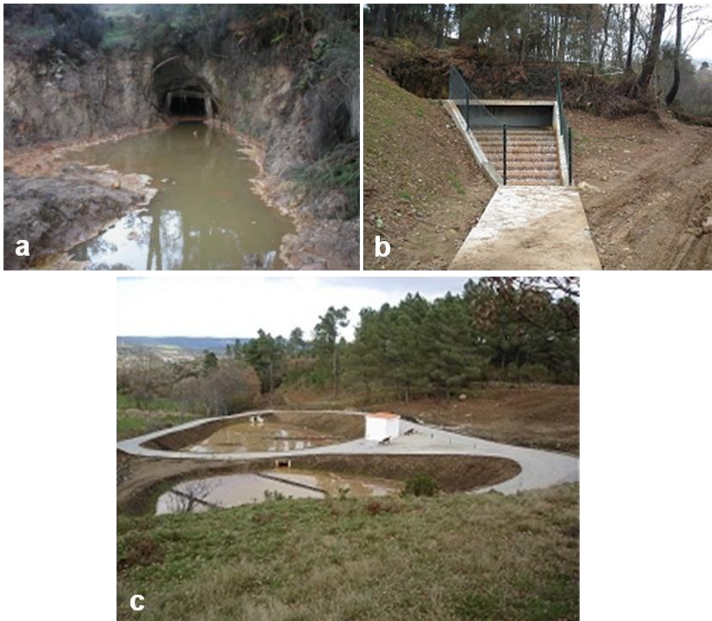
Figura 3.14 – Saída do efluente (a) e após intervenção (b), onde se destaca uma cascata de arejamento e o início do canal de neutralização. Wetlands , órgãos de tratamento biológico
