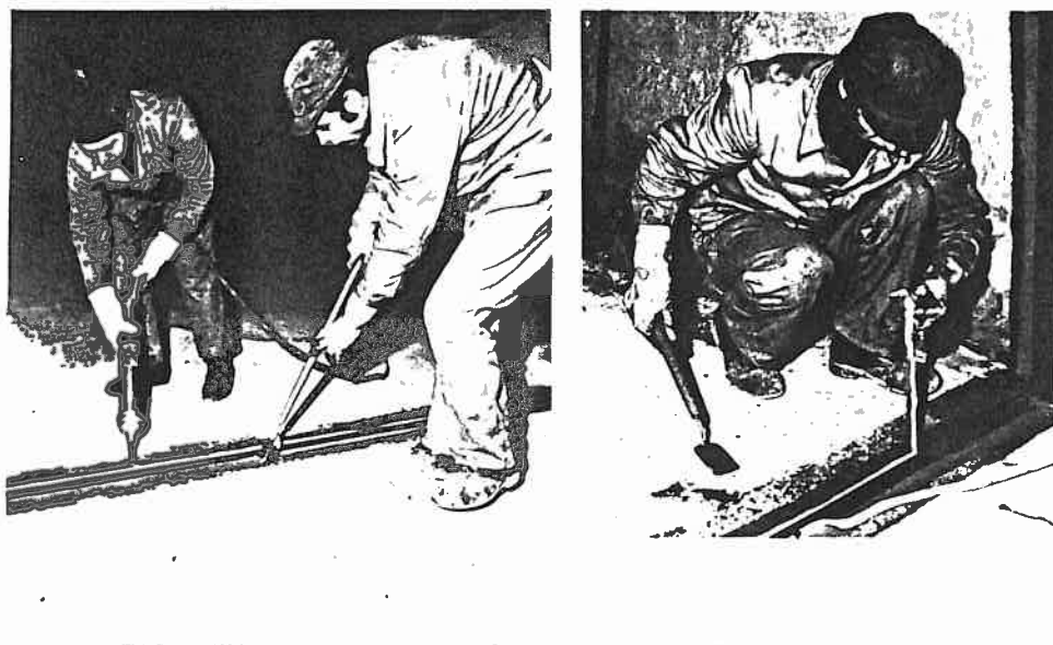
Fig.8 - Protecção de uma junta de dilatação com fita adesiva que é retirada após a aplicação
