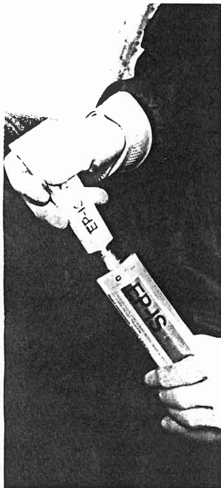
Fig. 21 - Introdução do endurecedor no cartucho que contém a resina
