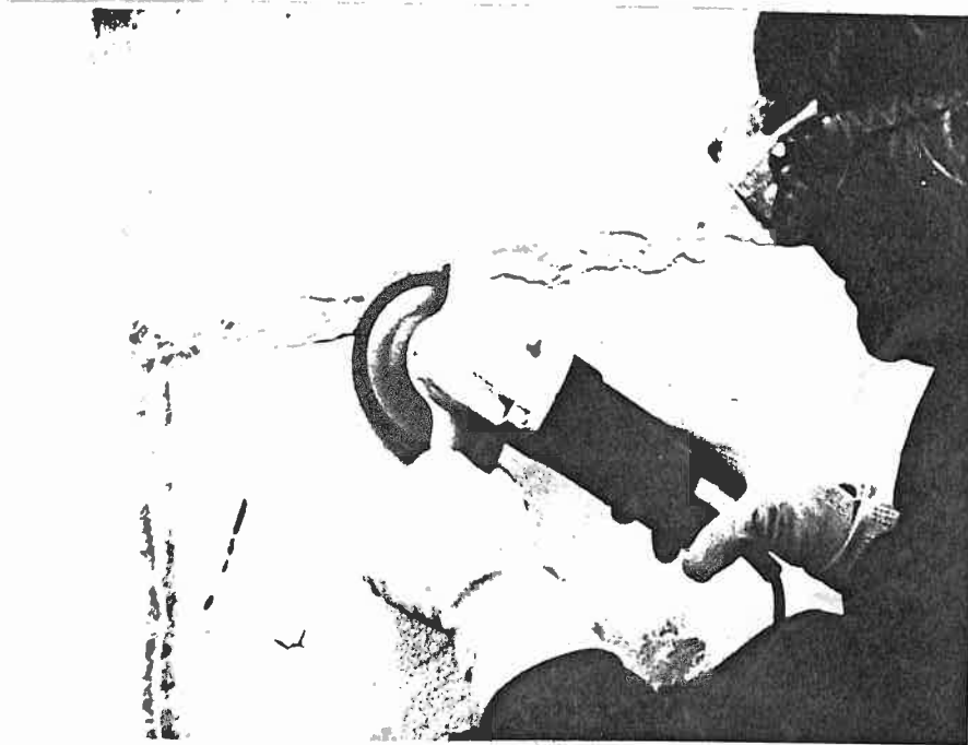
Fig. 26 - Eliminação do ligante selante com uma reverbadora de disco
