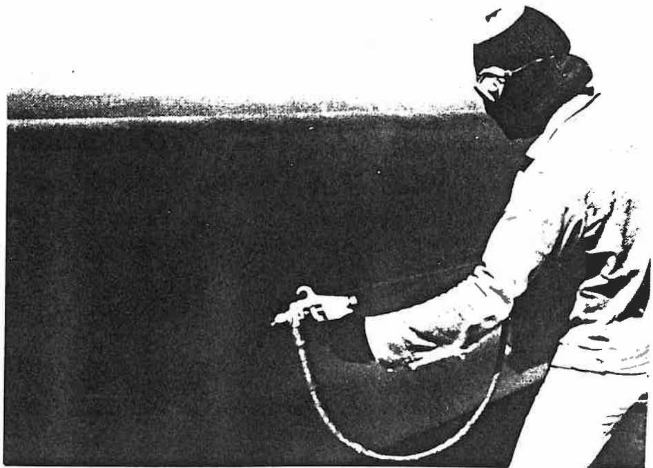
Fig. 9 - Equipamento de protecção a utilizar na aplicação de um composto epóxico à pistola.
