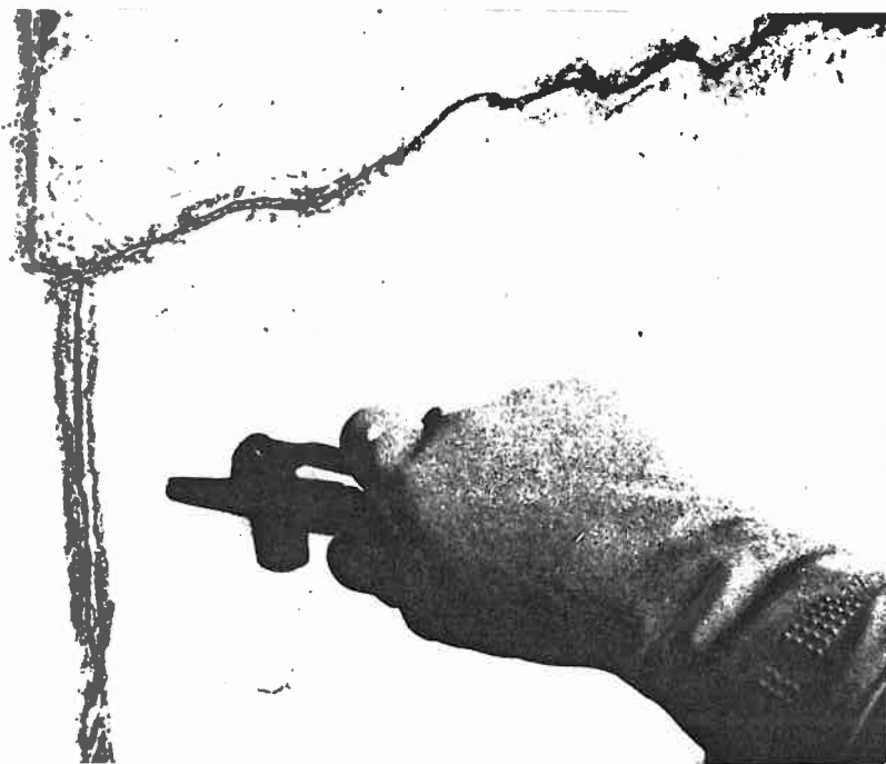
Fig.7 - Limpeza de uma fissura com jacto de ar comprimido
