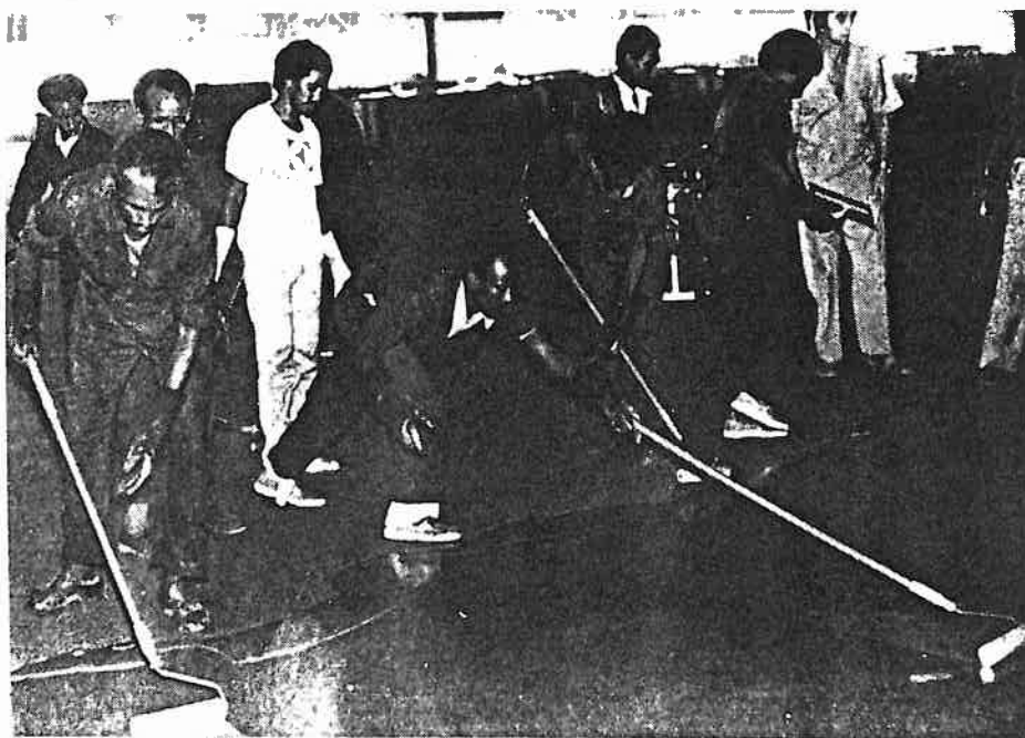
Fig. 10 - Aplicação de um ligante epóxico com rolêtes
