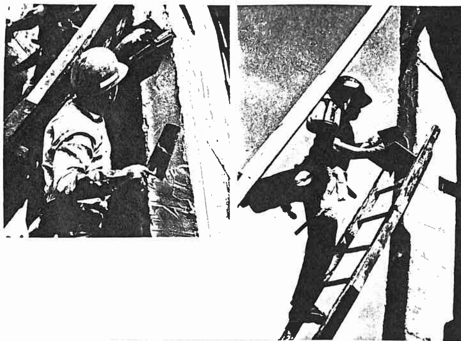
Fig. 17 - Aplicação de argamassa com uma colher em superfície vertical
