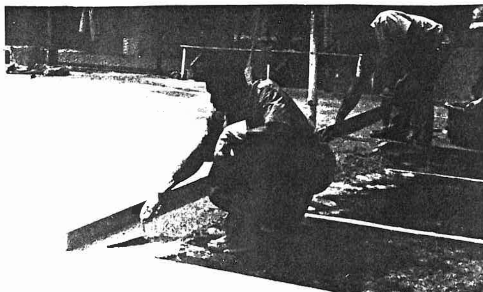
Fig. 16 - Aplicação de argamassa com uma colher em superfície horizontal
