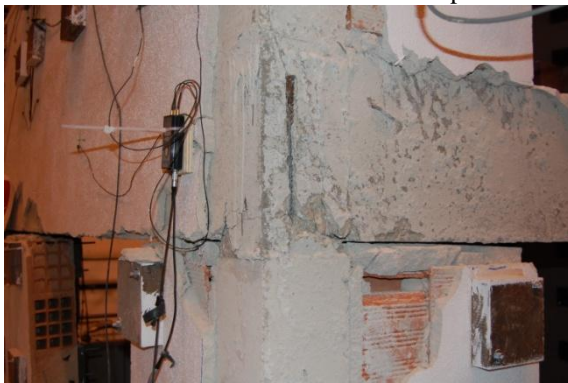
(d) Rótula no topo do pilar Nordeste do primeiro piso
