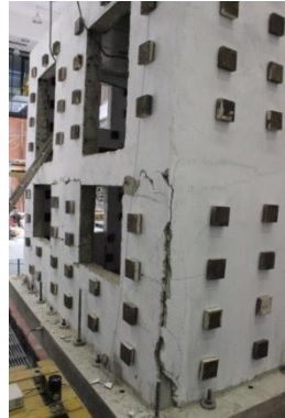
(a) Destacamento do reboco no canto Sudeste
