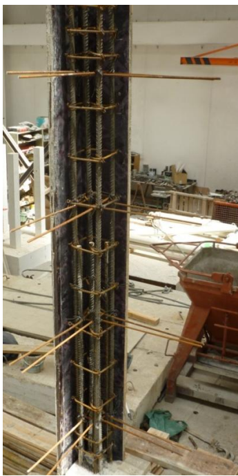
(b) Conectores metálicos ligados à armadura longitudinal dos pilares
