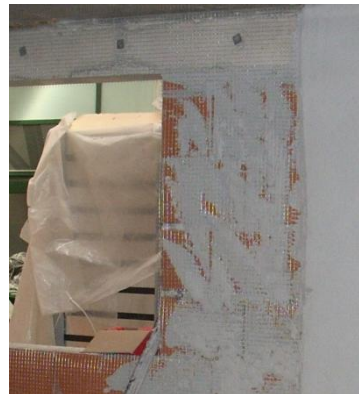
(d) Aplicação de reboco.
