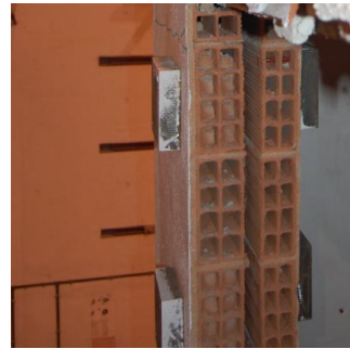
(b) Detalhe numa zona com abertura
