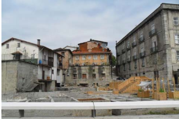
Fotografia 3. Local de Implantação do CEDOCAVE na Zona de Couros.
