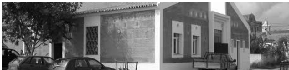
Figura 1. Construção contemporânea em taipa, Mercado de São Luís em Odemira (fonte: Teresa Beirão, 2003).
