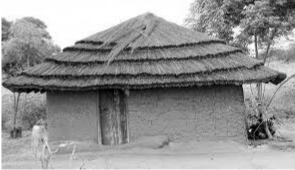
Figura 4. Residência construída com o sistema wattle and daub (fonte: CRAterre.org).
