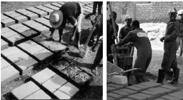
Figuras 5 e 6. Preparação de adobe e BTC (fonte: CRAterre.org).
