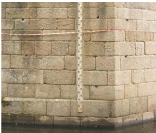
Fot. 7 - Escala hidrométrica de São Gonçalo.
