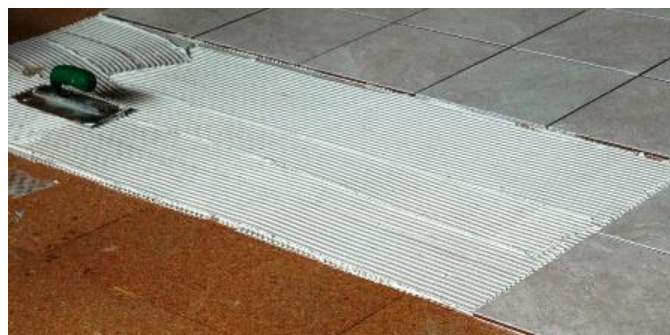
Figura 20 – Aplicação de cortiça em pisos (reproduzido de Acousticork, 2012)
