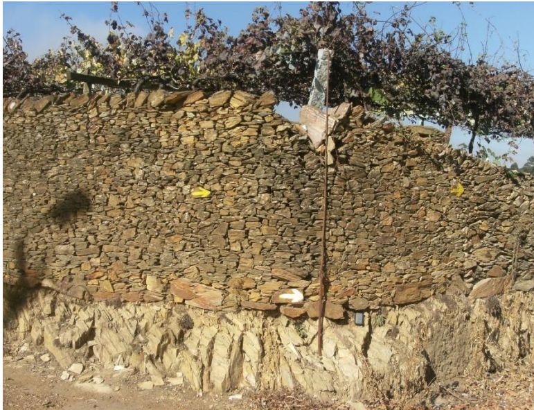
Fig. 37 - Afloramento de xistos sob uma estrutura antrópica de xisto na localidade de Rates
