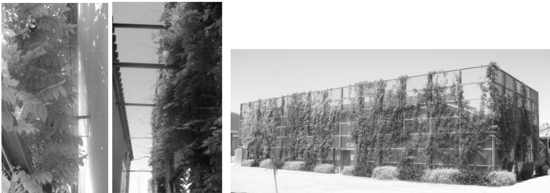
Figure 2. Theatre Lo Casal de Golmés green facade, 2008.
