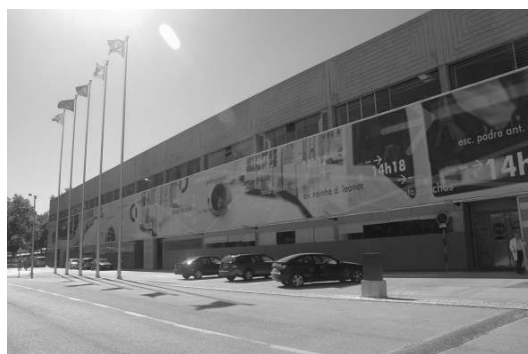
Figura 3. – Imagem exterior da fachada Sul
