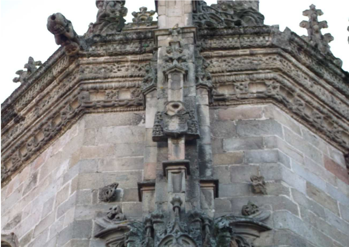
Ilustração 30 – Detalhe do contraforte com o brasão de D. Diogo de Sousa
