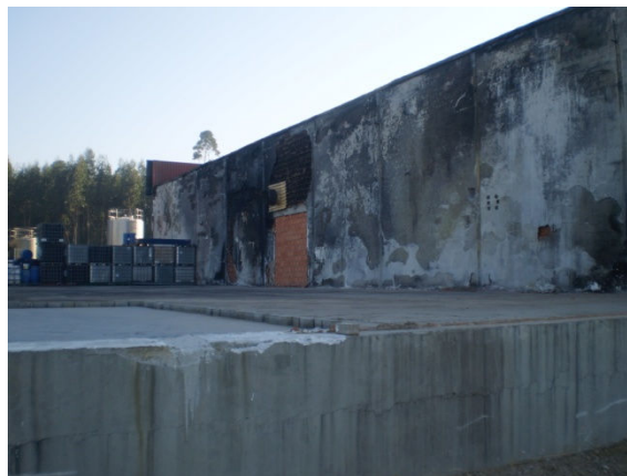
Figura 6.2 – Piso do Rés-do-Chão (após remoção da estrutura metálica)
