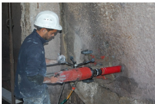
Figura 6.36 – Extração de carote em muro de suporte
