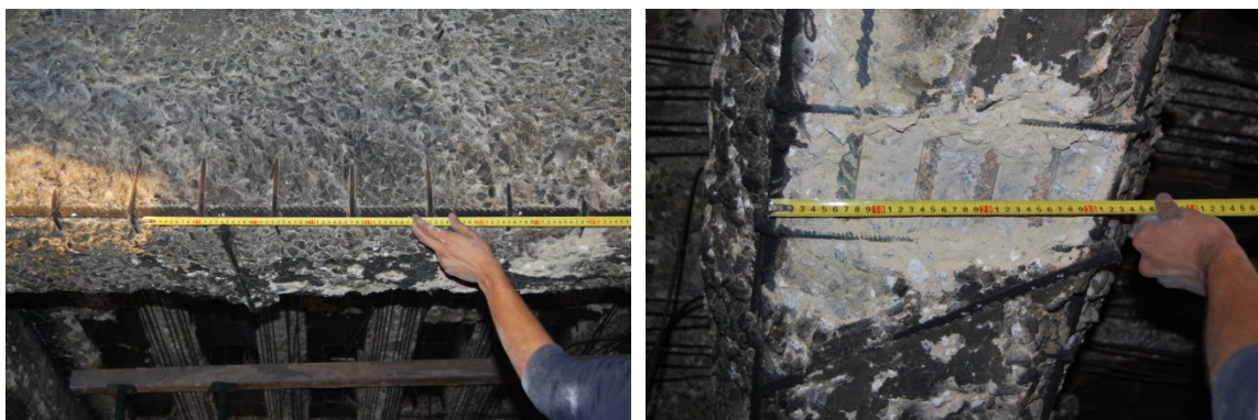
Figura 6.9 – Verificação da armadura existente acessível em V1
