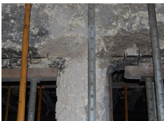
a) Condições representativas da ligação pilar-viga
