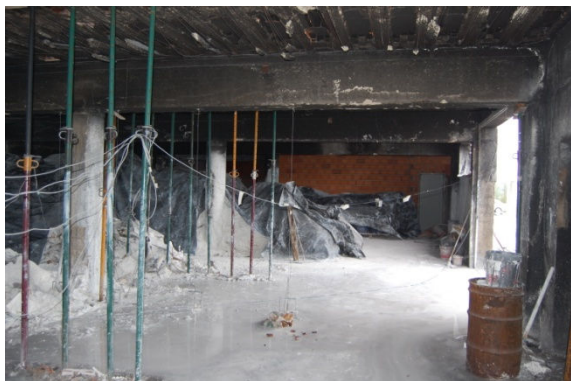
Figura 6.37 – Ensaio de Carga – Pórtico 5 / Tramo 1
