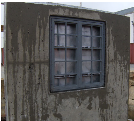
Figura 3.71 – Betonagem de protótipo de parede para moradia
