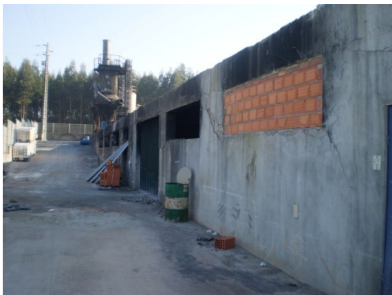
Figura 6.1 – Piso da Cave (elementos em betão)
