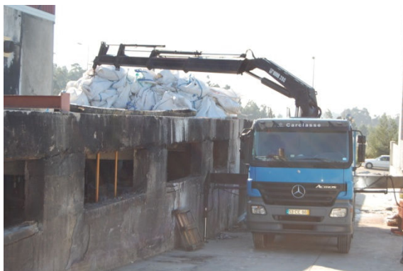
Figura 6.39 – Primeira fase (carga com sacos de brita)
