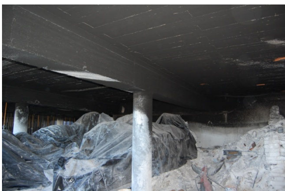
Figura 6.29 – Vigas com integridade (a verde na Figura 6.33)
