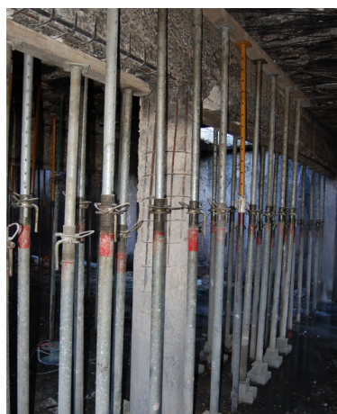
Figura 6.28 – Pilar com destaque significativo do betão de recobrimento
