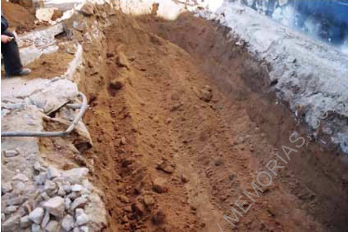
Foto 5 - Trabalhos de desaterro mecânico na Sond.2 (E/O).
