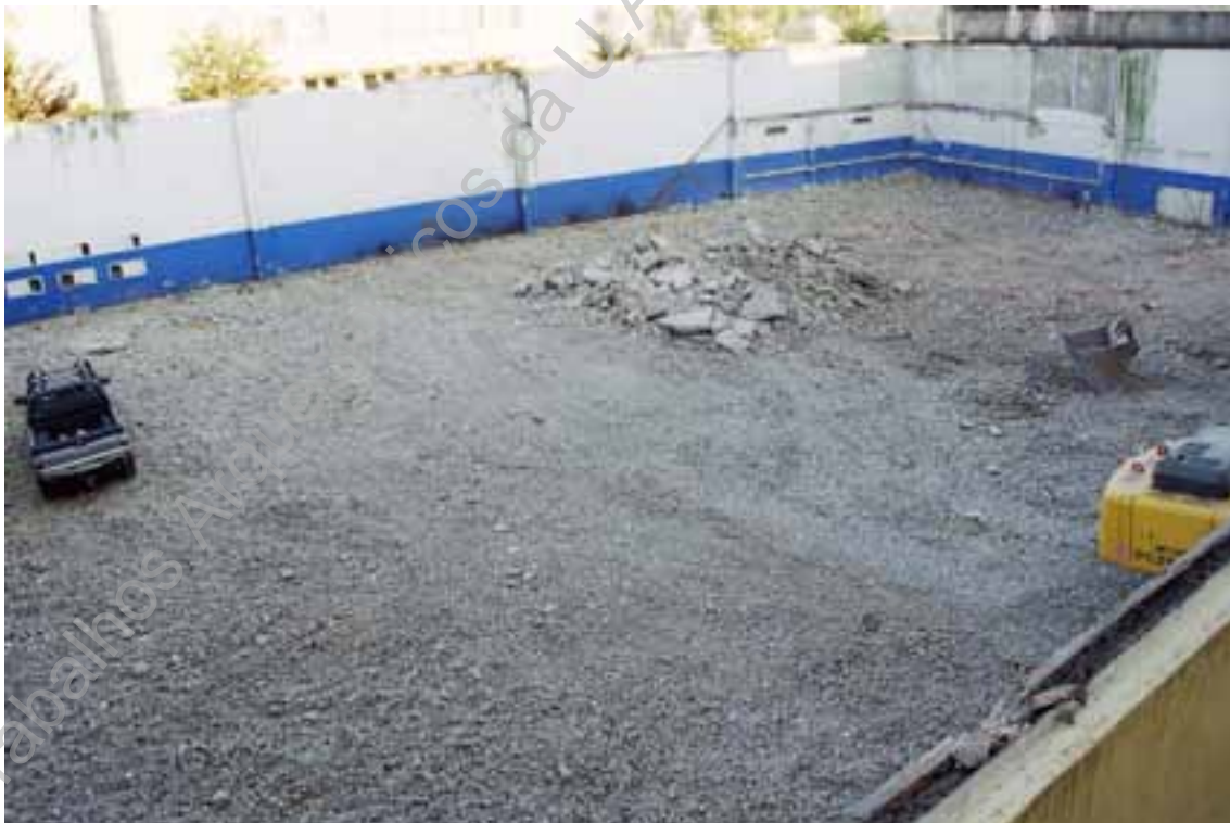
Foto 2 - Perspectiva geral dos trabalhos de demolição (NO/SE).
