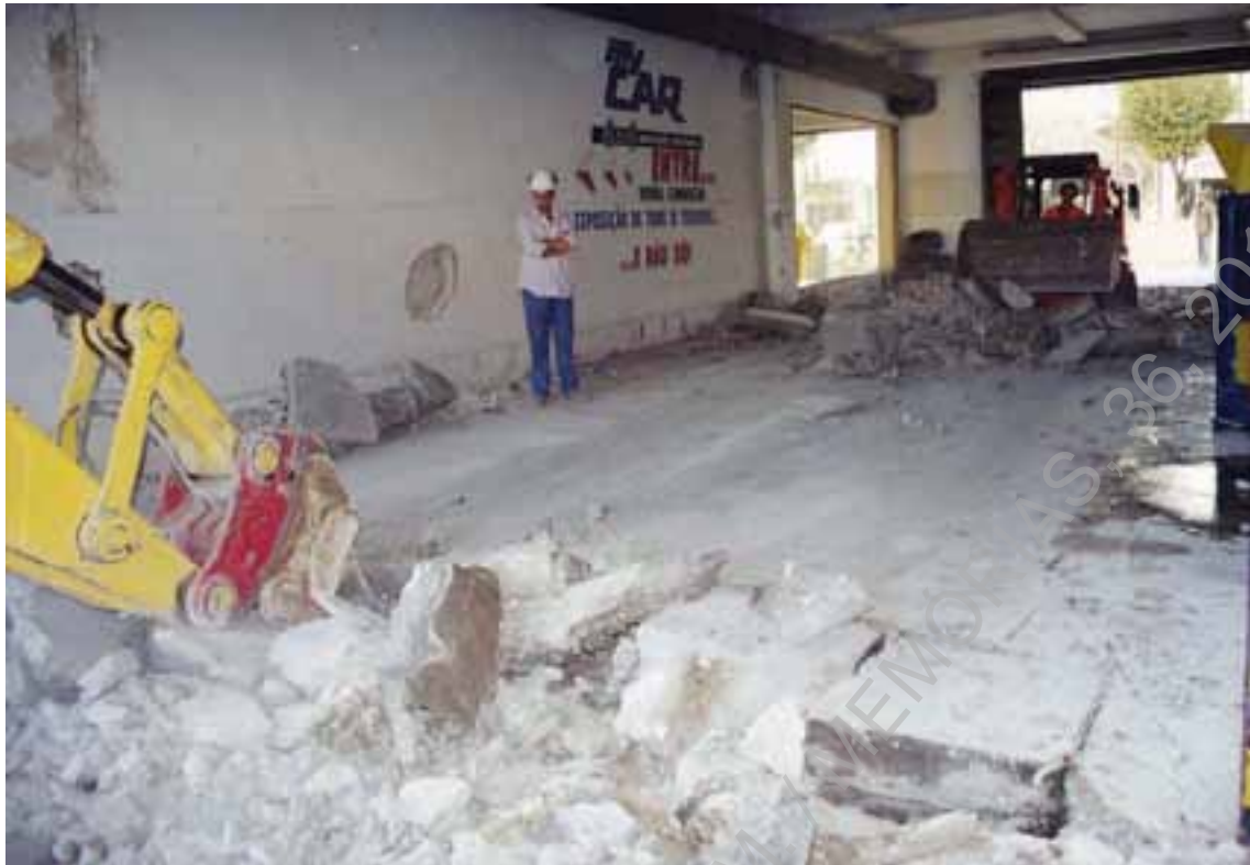
Foto 1 - Aspecto geral dos trabalhos de remoção do piso UE100 (NE/SO).
