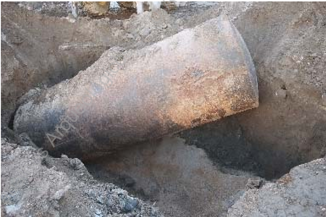
Foto 14 – Remoção do tanque de gasóleo (UE180).
