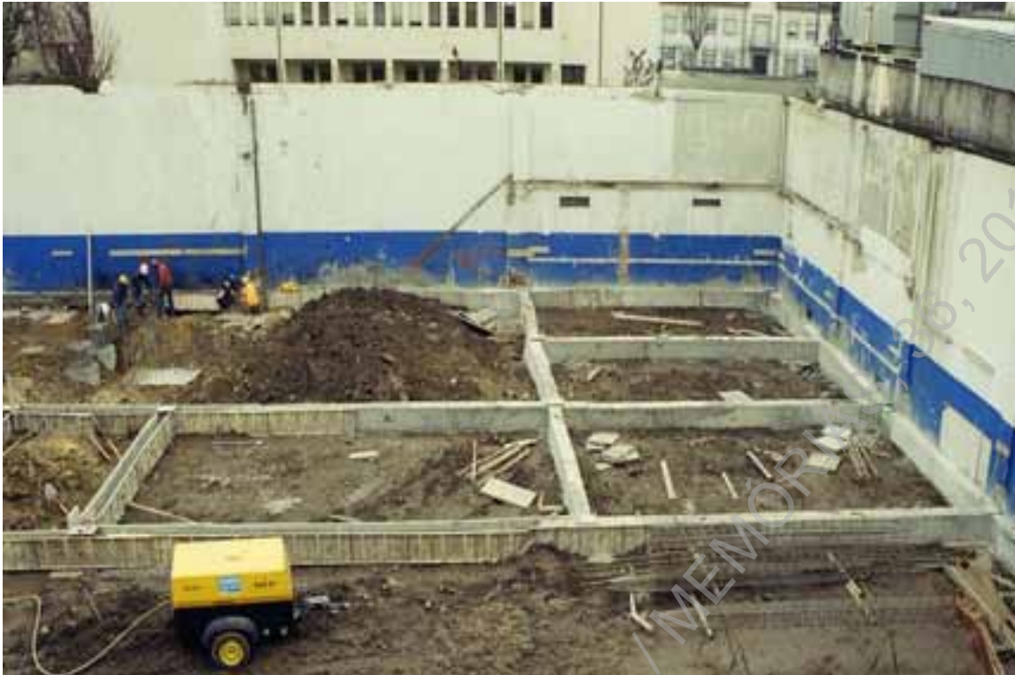
Foto 18 – Perspectiva do terreno já com as infra-estruturas de suporte para o novo pavimento.
