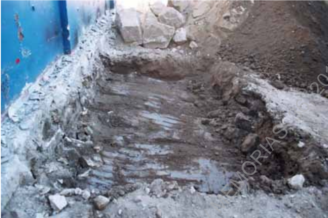
Foto 9 - Vista geral dos trabalhos de desaterro mecânico da Sond.5 (O/E).
