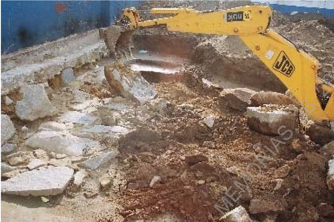
Foto 11 – Perspectiva do desmonte da calçada encontrada na sondagem 3 (UE139).
