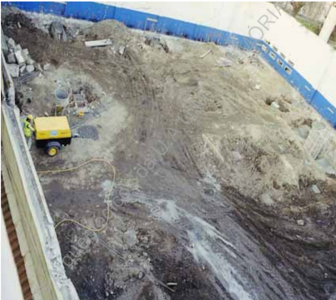
Foto 17 – Perspectiva do terreno já com as micro estacas implantadas.
