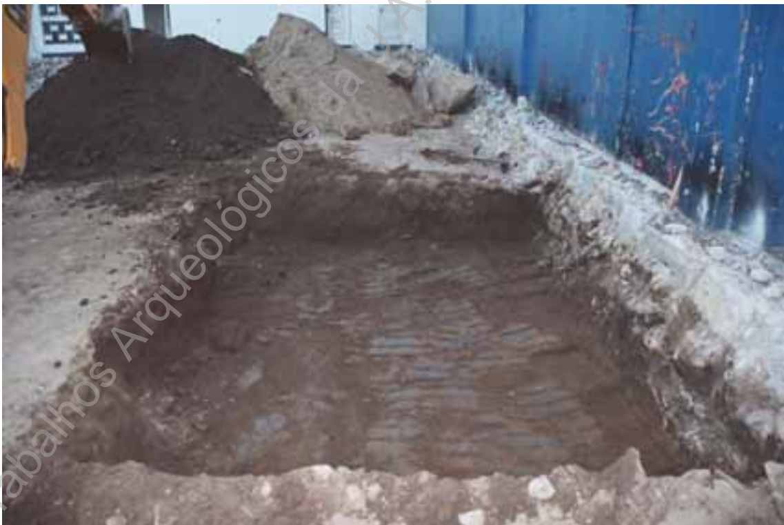
Foto 8 - Aspecto geral dos trabalhos de desaterro mecânico da Sond.4 (E/O).
