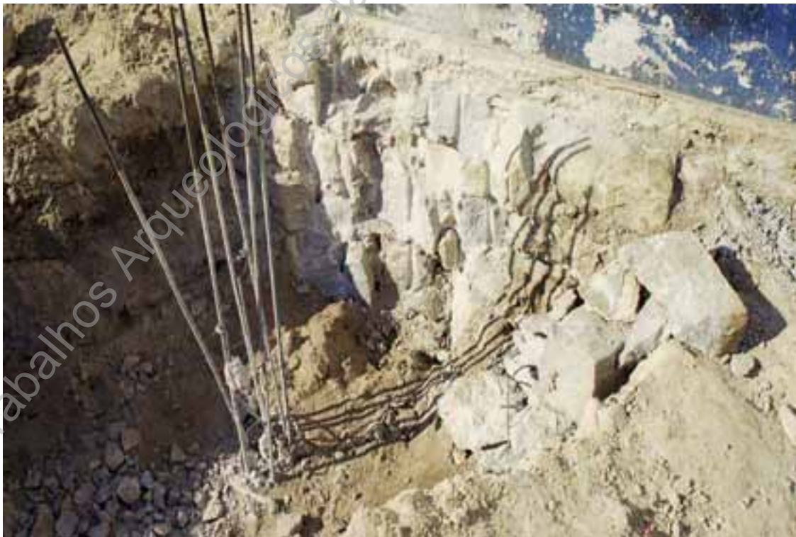
Foto 16 – Pormenor de uma micro estaca já saneada
