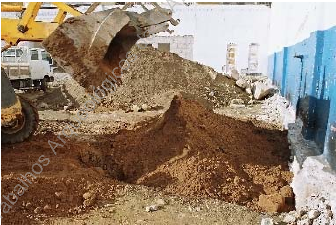
Foto 12 – Perspectiva do entulhamento da sondagem 3.
