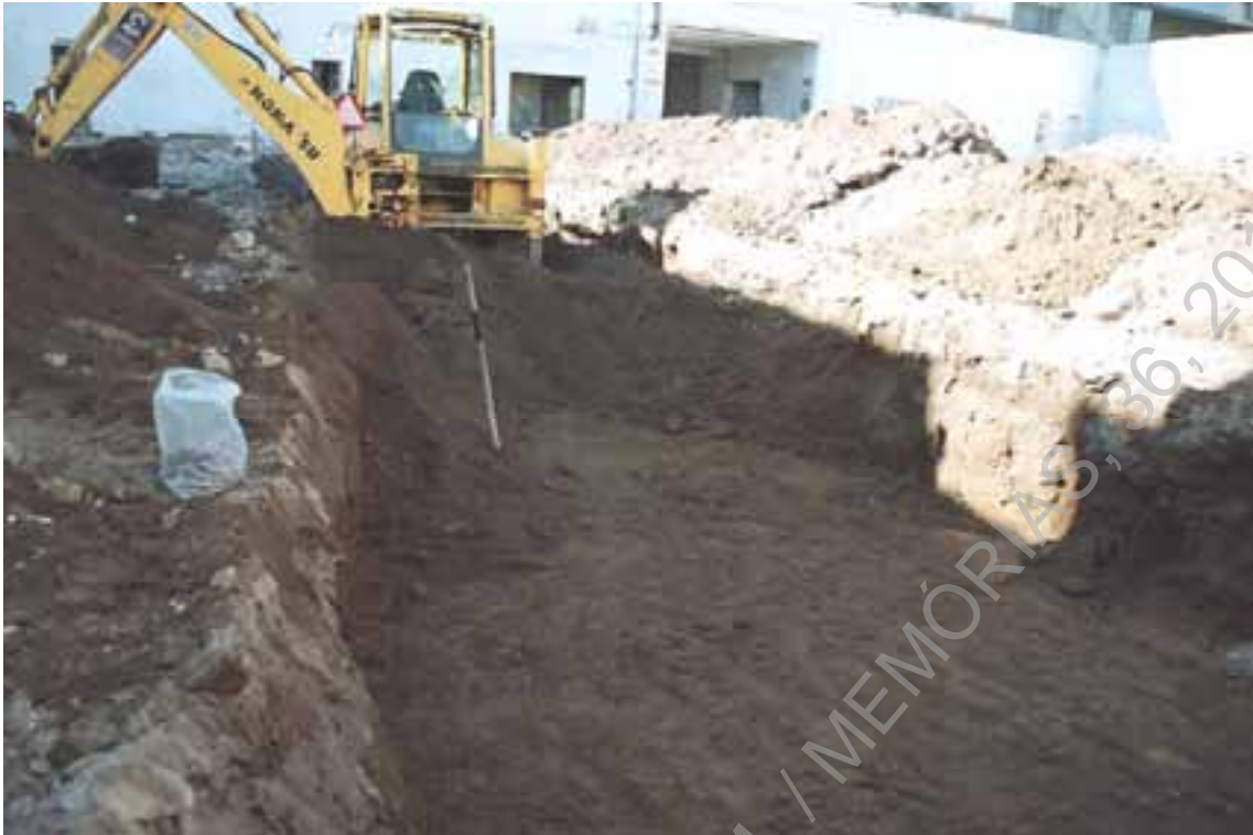
Foto 3 - Trabalhos de desaterro mecânico na Sond.1 (SE/NO).
