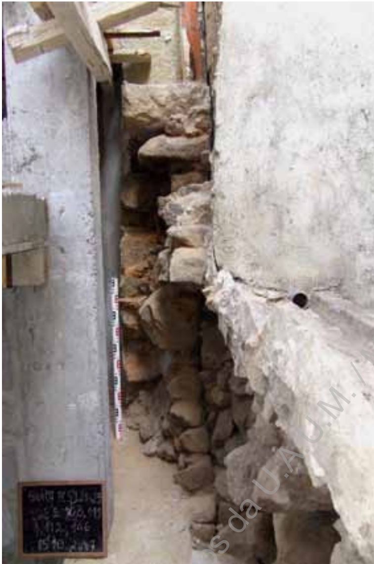
Foto 33 – Secção B: estrutura UE108, 111 e 146.
