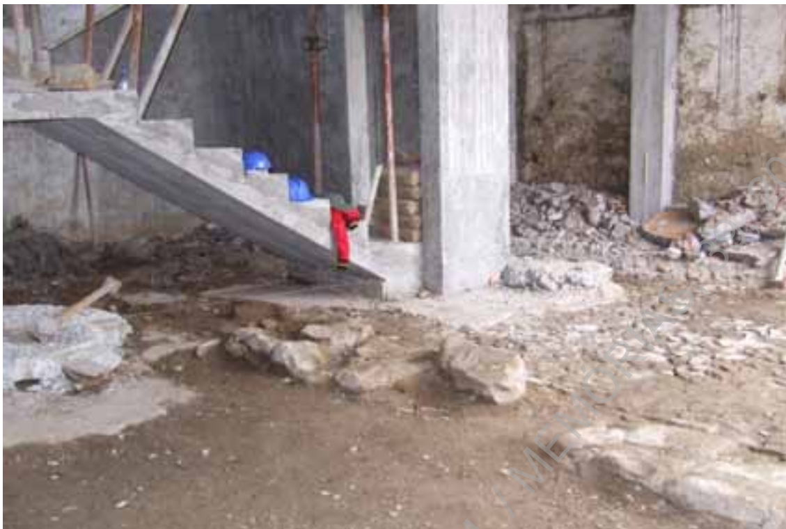
Foto 1 – Aspecto geral da zona onde se realizaram os trabalhos.
