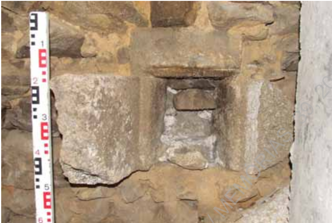
Foto 34 – Pormenor da UE148 (possível drenagem).
