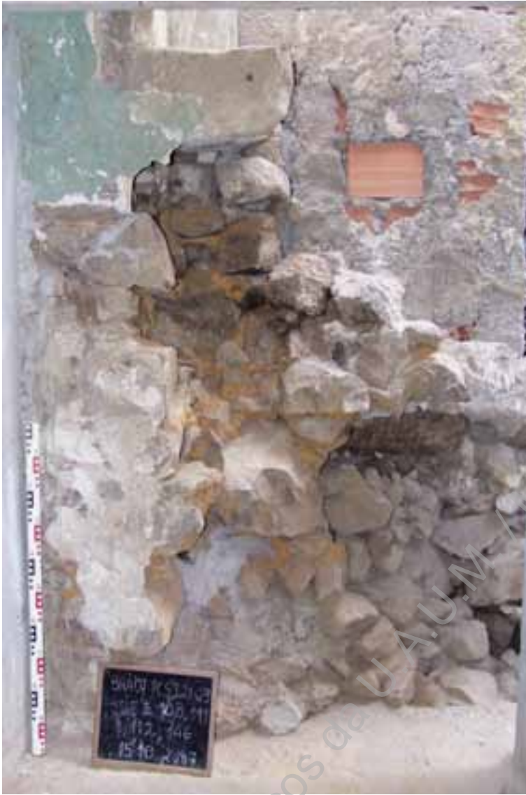
Foto 29 – Alçado da UEs111, 112 e 146, onde se observa o miolo UE108.
