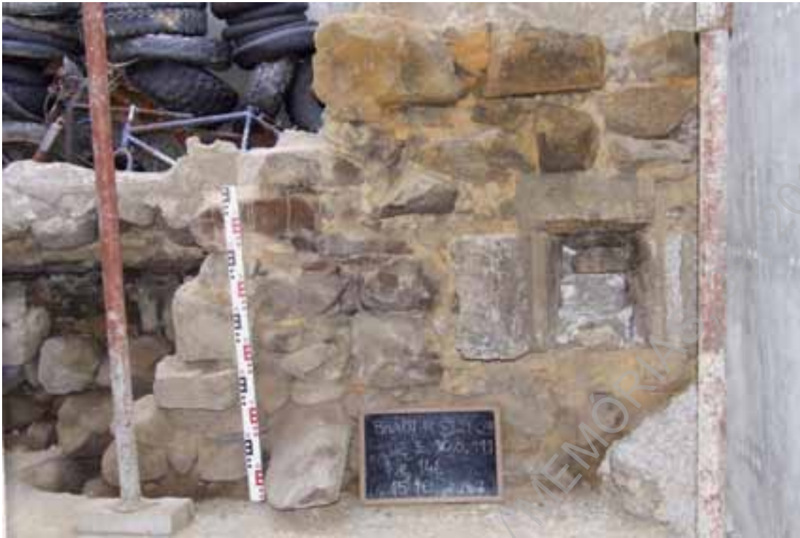
Foto 30 – Alçado das UEs 111, 146 e 148, onde se observa o miolo UE108.
