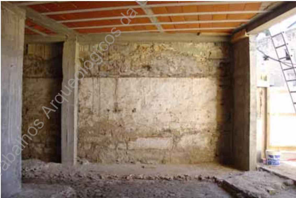
Foto 37 – Perspectiva da parede que limita o imóvel a Oeste UE114.
