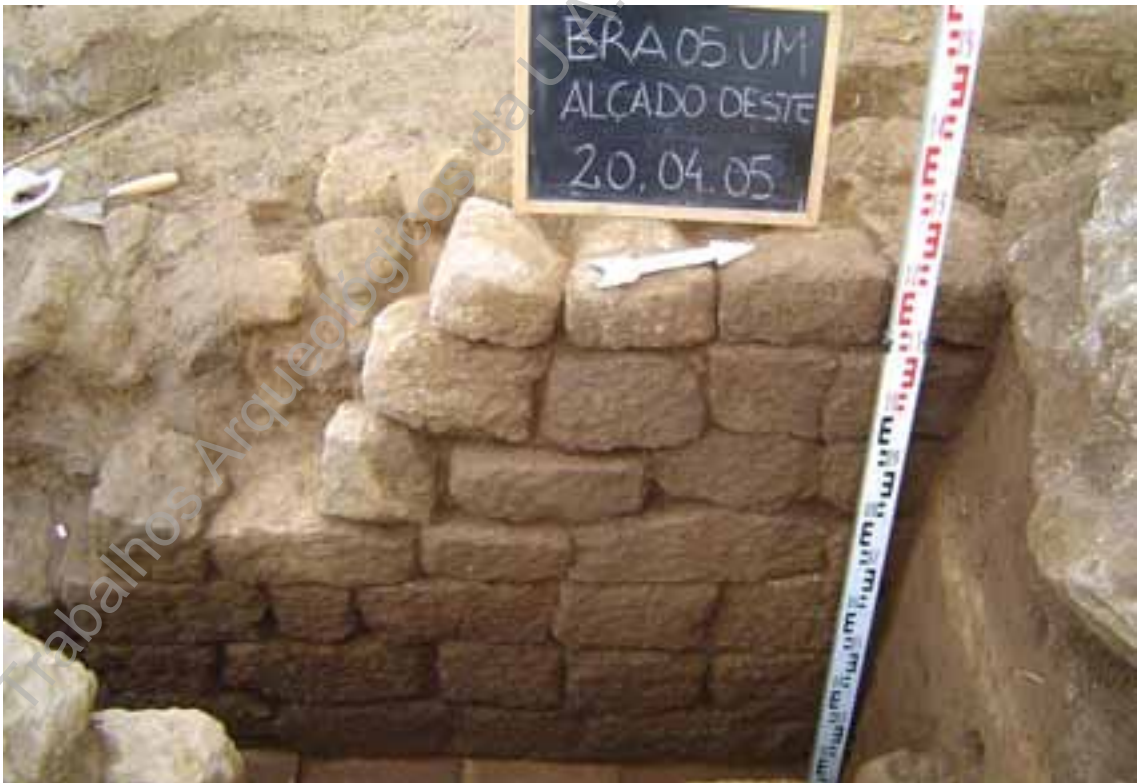
Foto 2 – Alçado Oeste da canalização (Sector K9), com paredes em blocos graníticos faceados pelo interior e assentes em junta seca.
