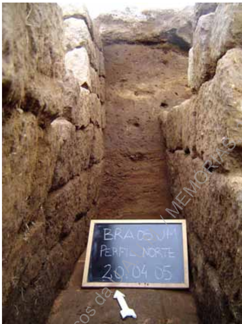
Foto 9 – Corte Norte da canalização, onde se destaca o pormenor da UE06.
