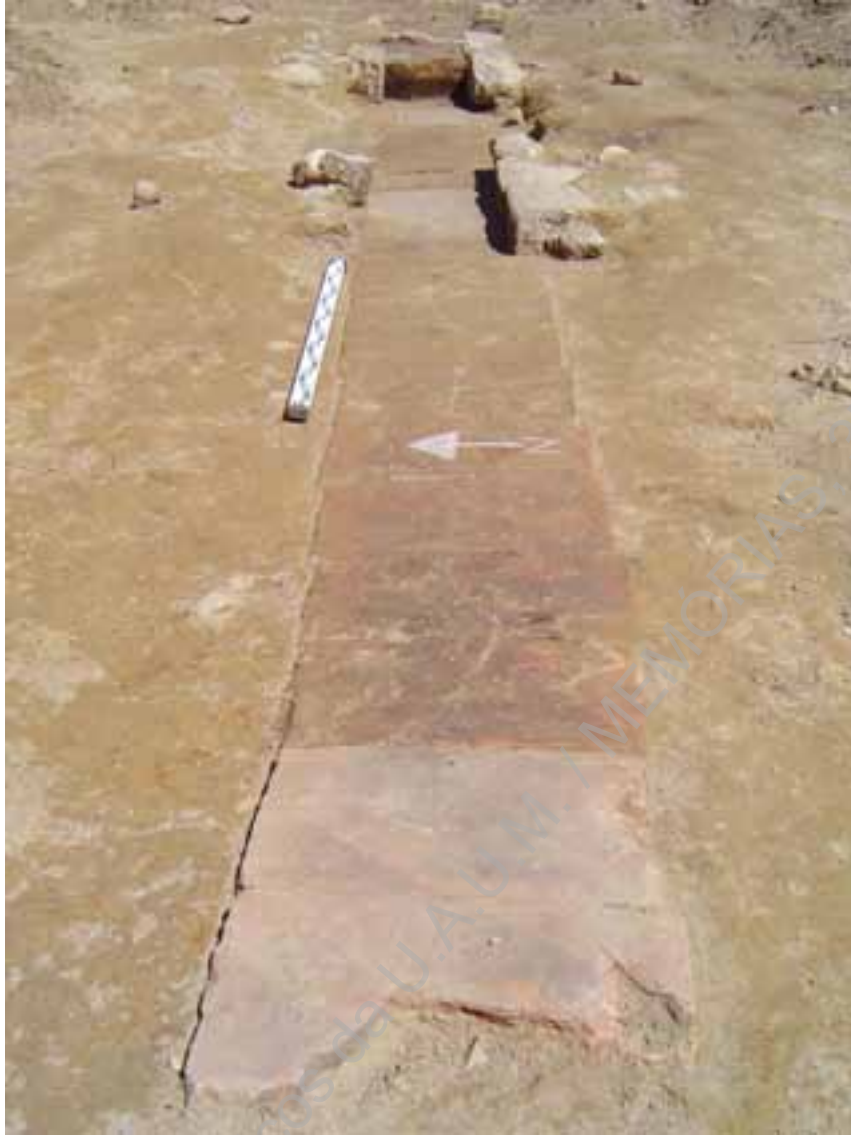
Foto 4 – Vista das tijoleiras a retirar, para a implementação de uma vala para conduta de gás.
