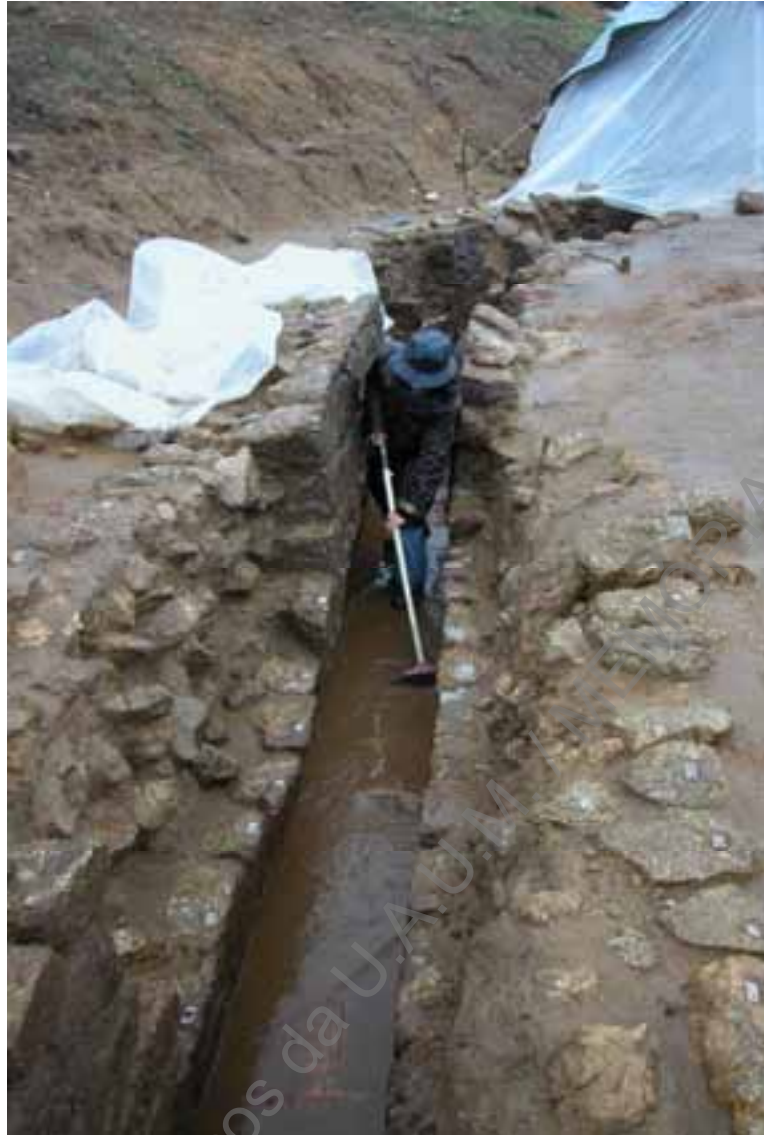
Foto 19- Aspecto das inundações causadas pelas fortes chuvadas.
