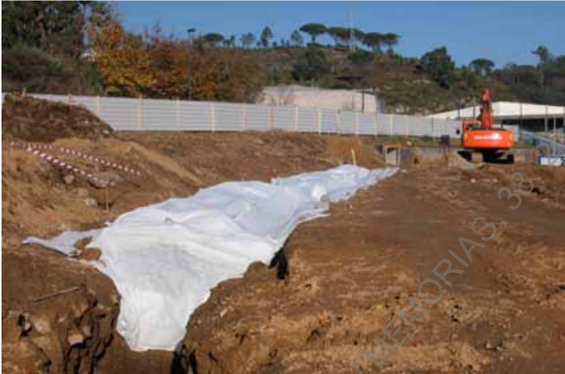
Foto 20- Acompanhamento do processo de cobertura do Tramo B, com geotêxtil.
