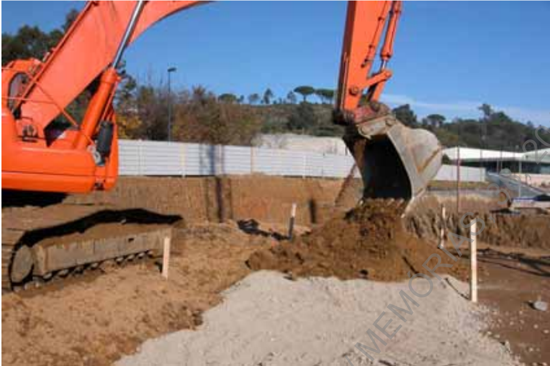
Foto 22- Etapa final cobertura com uma camada de terra.
