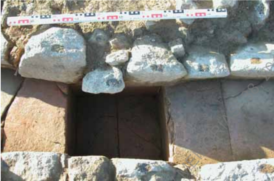
Foto 17- Pormenor de um dos aspectos construtivos da canalização: a caixa de água.
