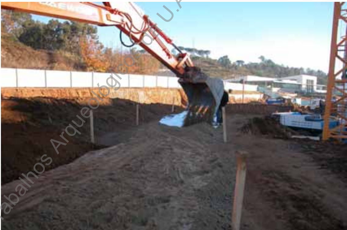
Foto 21- Colocação de uma segunda protecção, esta composta por gravilha.
