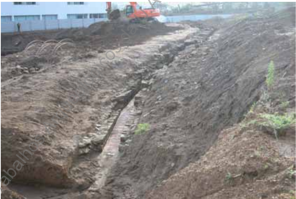
Foto 5 - Tramo C, vista Norte – Sul.
