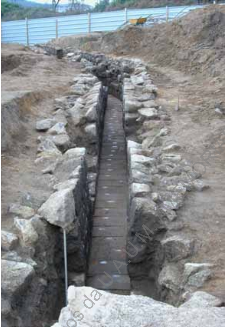
Foto 1 - Tramo A, perspectiva Norte – sul.
