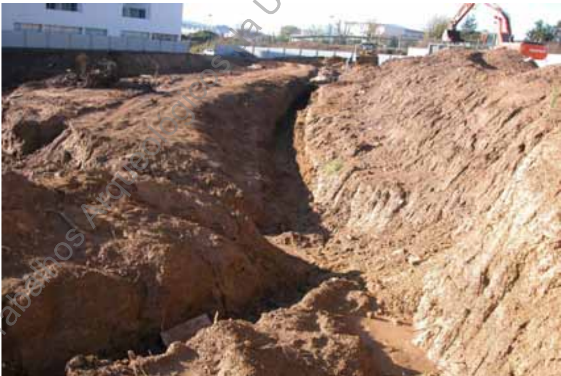
Foto 16- Vista do Tramo C (Norte-Sul), depois de se ter procedido à desmontagem.
