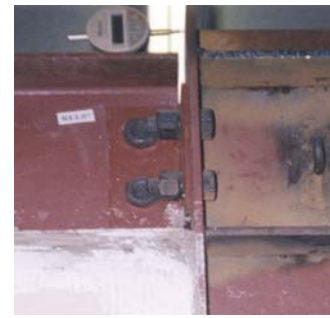
(c) Relógio comparador da ligação semi-rígida viga/pilar.
