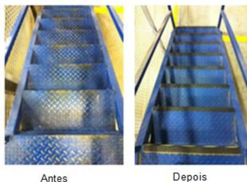
Figura 70 - Colocação de fita antiderrapante nas escadas.
