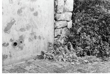
**34.** *Enxertia de Garfo*, Lugar do Meio, Areosa, Viana do Castelo, Fevereiro de 2013. Muro de granito pré-existente com muro de betão armado de loteamento recente.
