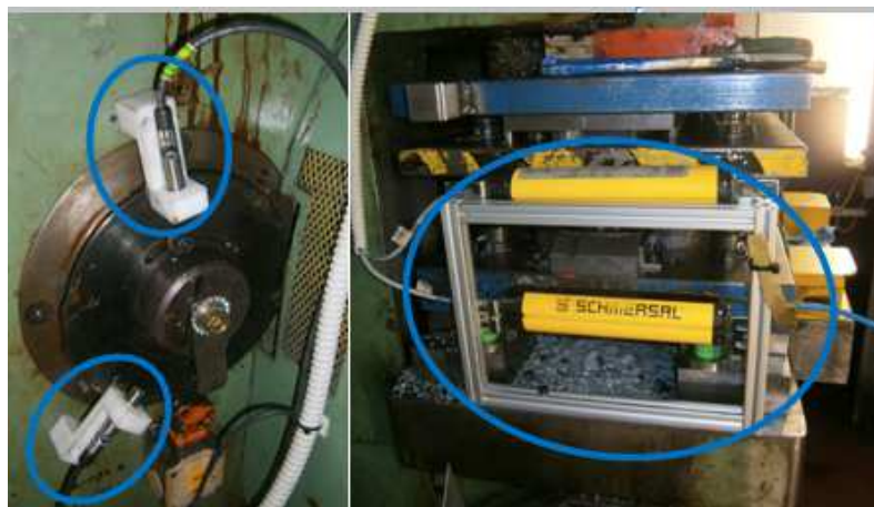
Figura 60: Mecanismo poka-yoke instalado nas prensas
