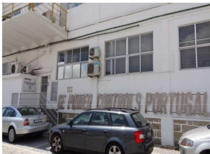
Figura 7: Fachada da empresa
