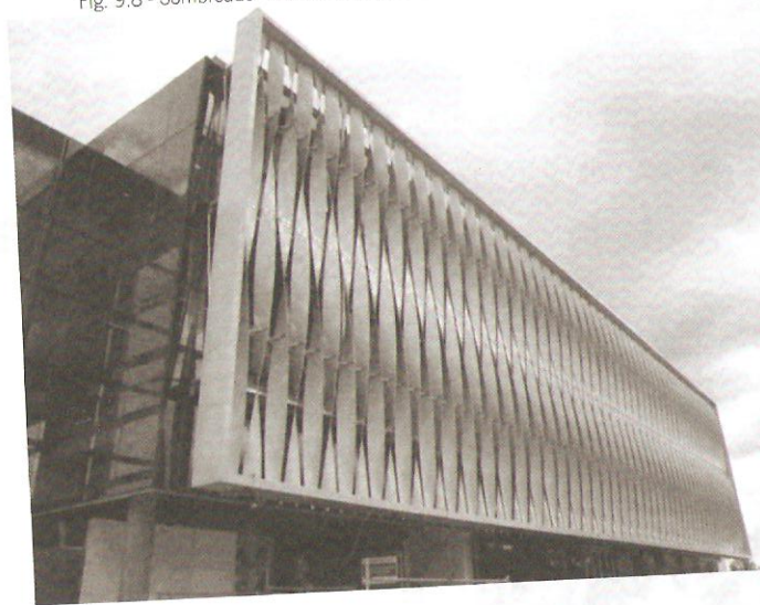
Fig. 9.8 - Sombreador exterior em Edifício na Universidade de Waikato, Nova Zelândia.
