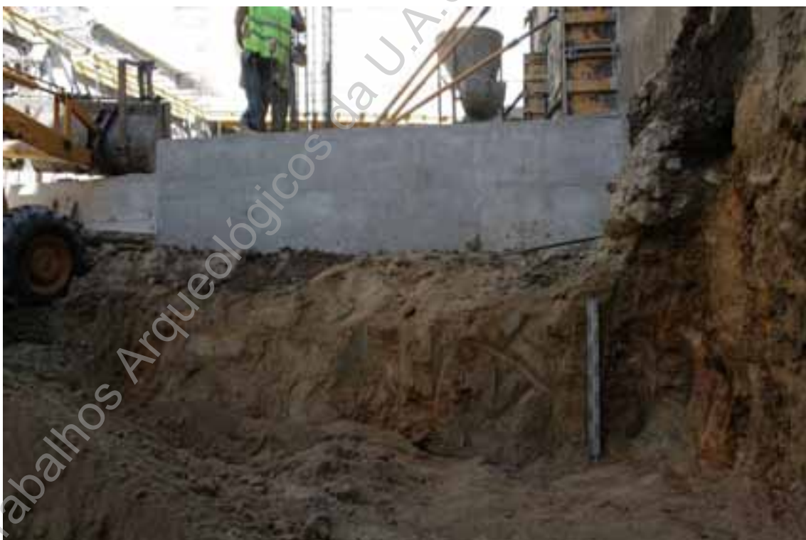
Foto 41: (UAUM – IMG_8093) Perfil Este – (O/E).
