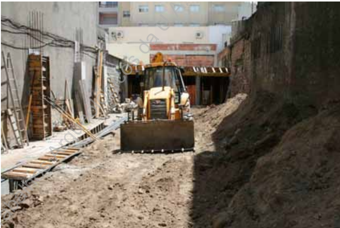
Foto 22: (UAUM – IMG_7820) Aspecto geral da obra – (O/E).
