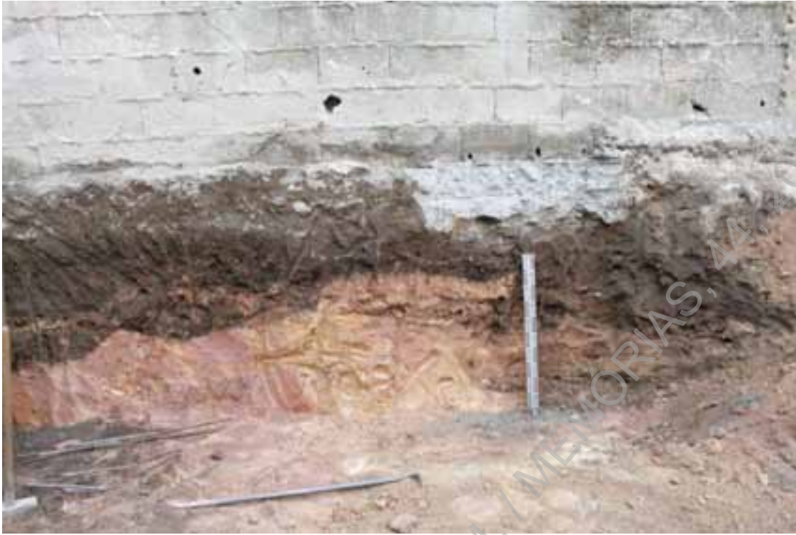
Foto 14: (UAUM – IMG_7553) Pormenor do perfil Norte da área de intervenção – (S/N).
