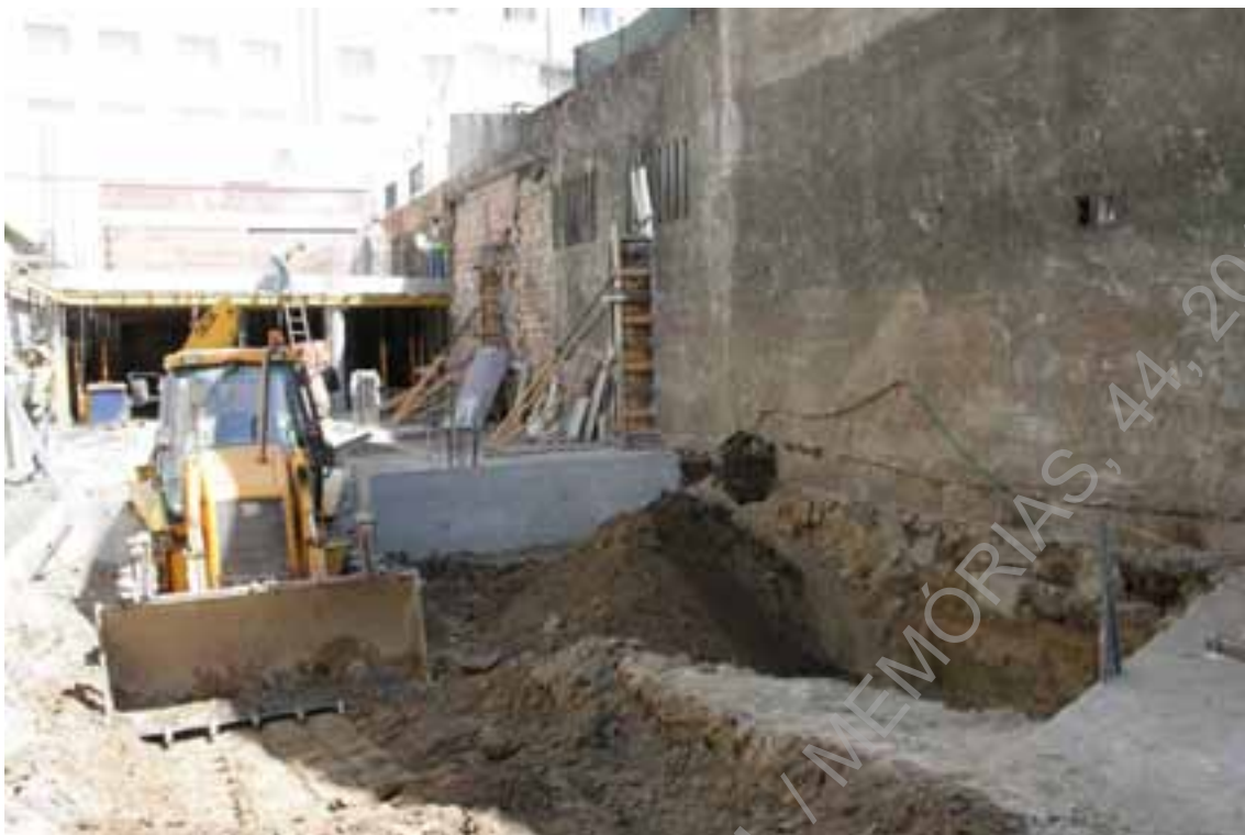
Foto 38: (UAUM – IMG_8081) Desaterro e abertura de vala – (E/O).
