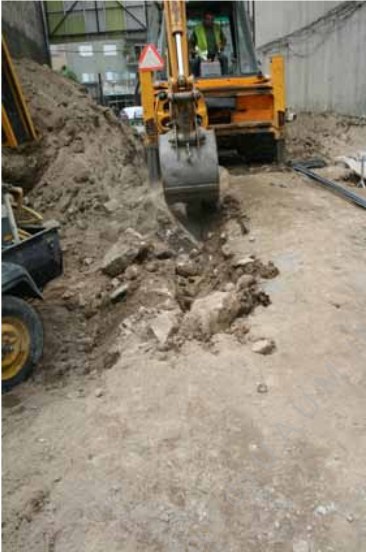
Foto 20: (UAUM – IMG_7723) Abertura vala para sapata – (E/O).
