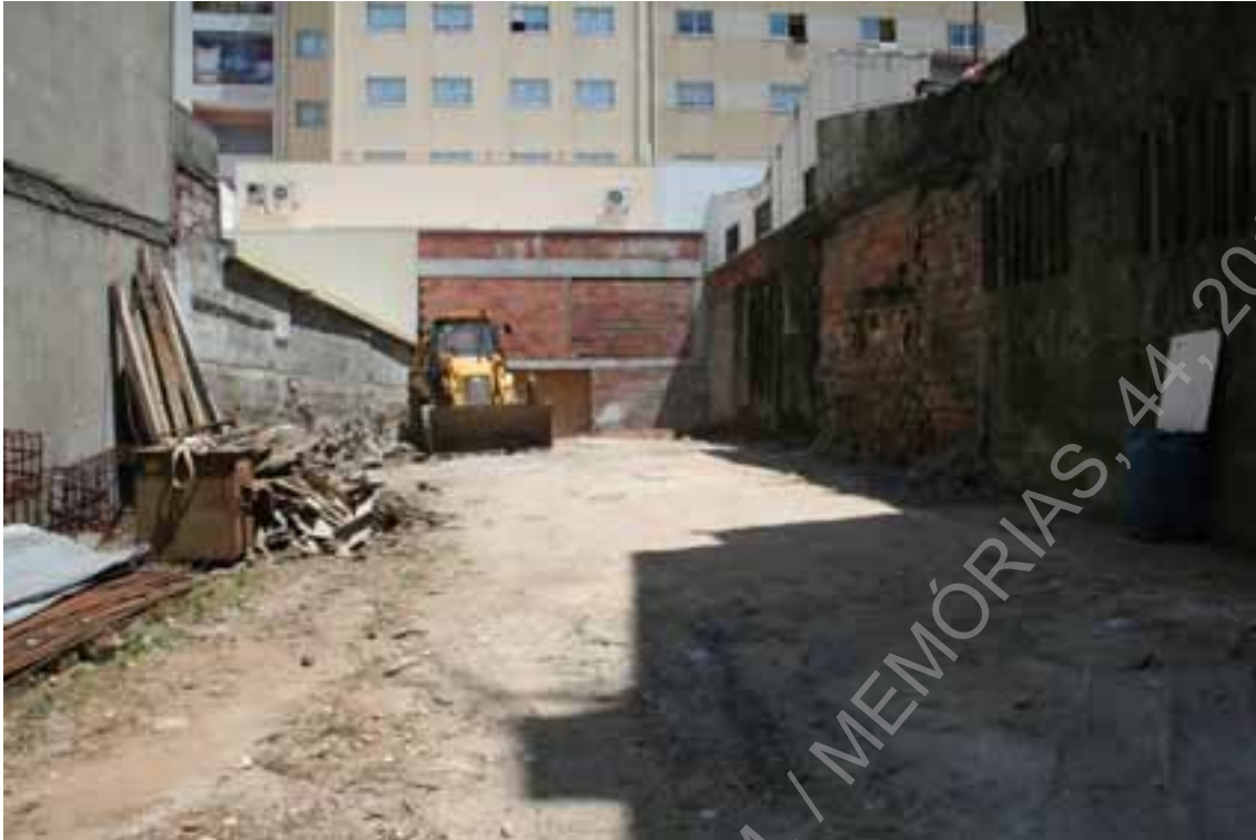
Foto 1: (UAUM – IMG_7354) Vista geral da área a intervir – (O/E).
