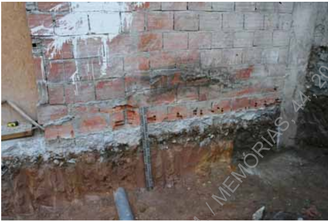
Foto 12: (UAUM – IMG_7548) Pormenor do perfil Este da área de intervenção – (O/E).
