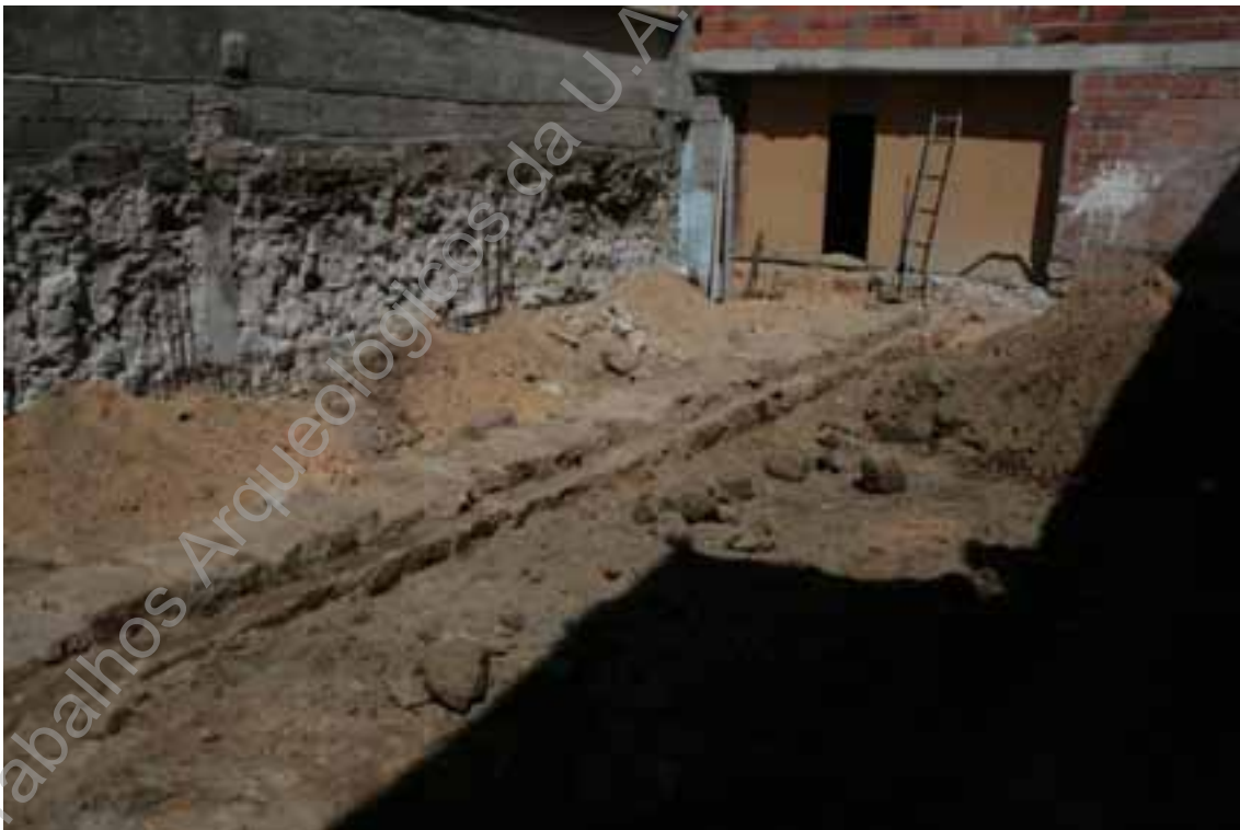
Foto 7: (UAUM – IMG_7505) Vista geral metade Este da conduta UE0001 – (SE/NO).
