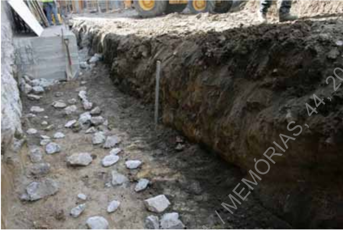
Foto 21: (UAUM – IMG_7787) Vala aberta – (O/E).
