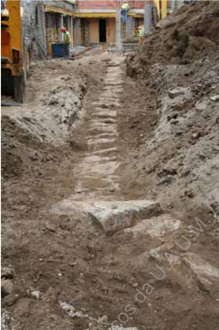
Foto 17: (UAUM – IMG_7679) Vista parcial metade Oeste da conduta UE0001 – (O/E).
