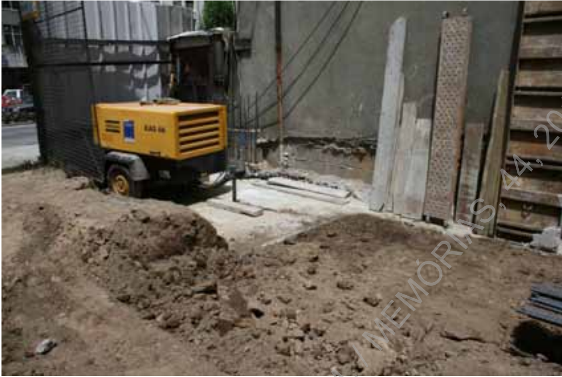
Foto 23: (UAUM – IMG_7821) Pormenor sapata concluída – (SE/NO).
