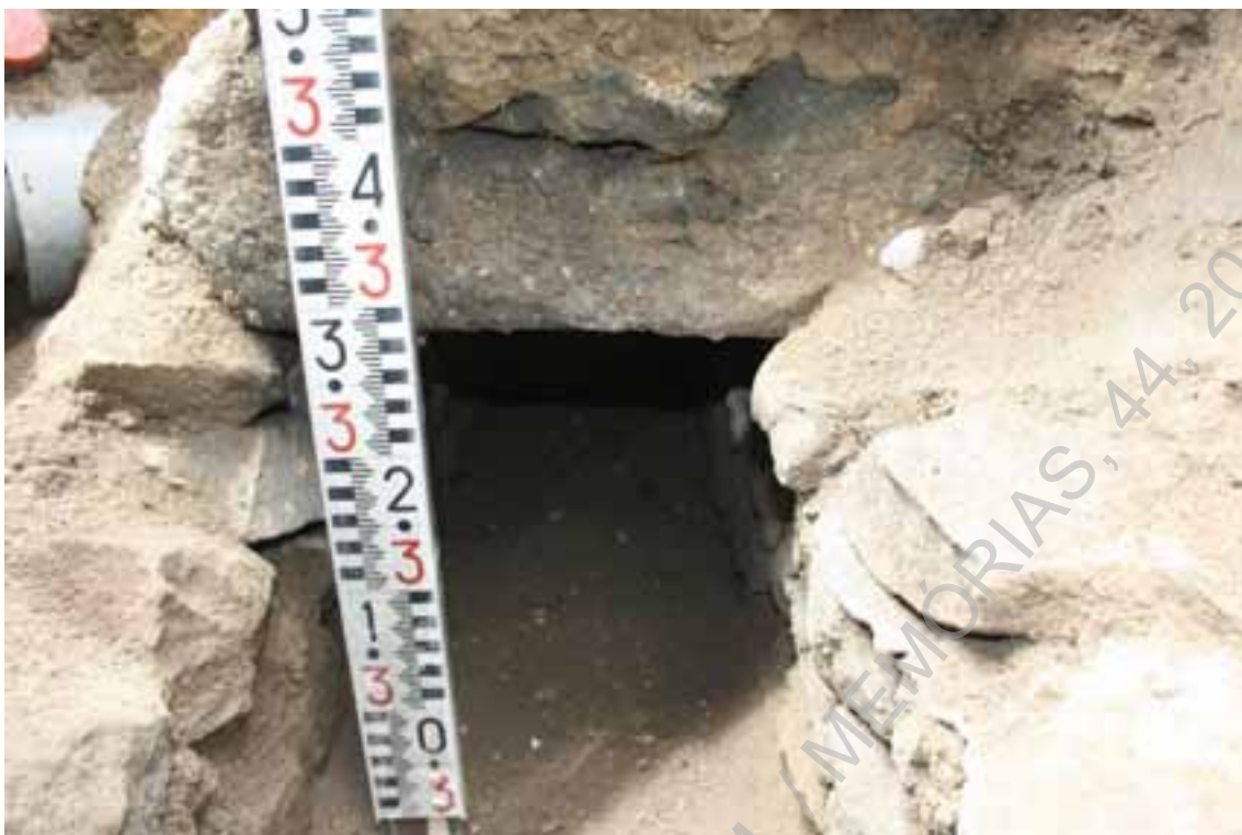
Foto 19: (UAUM – IMG_7701) Secção da conduta UE0001 – (E/O).
