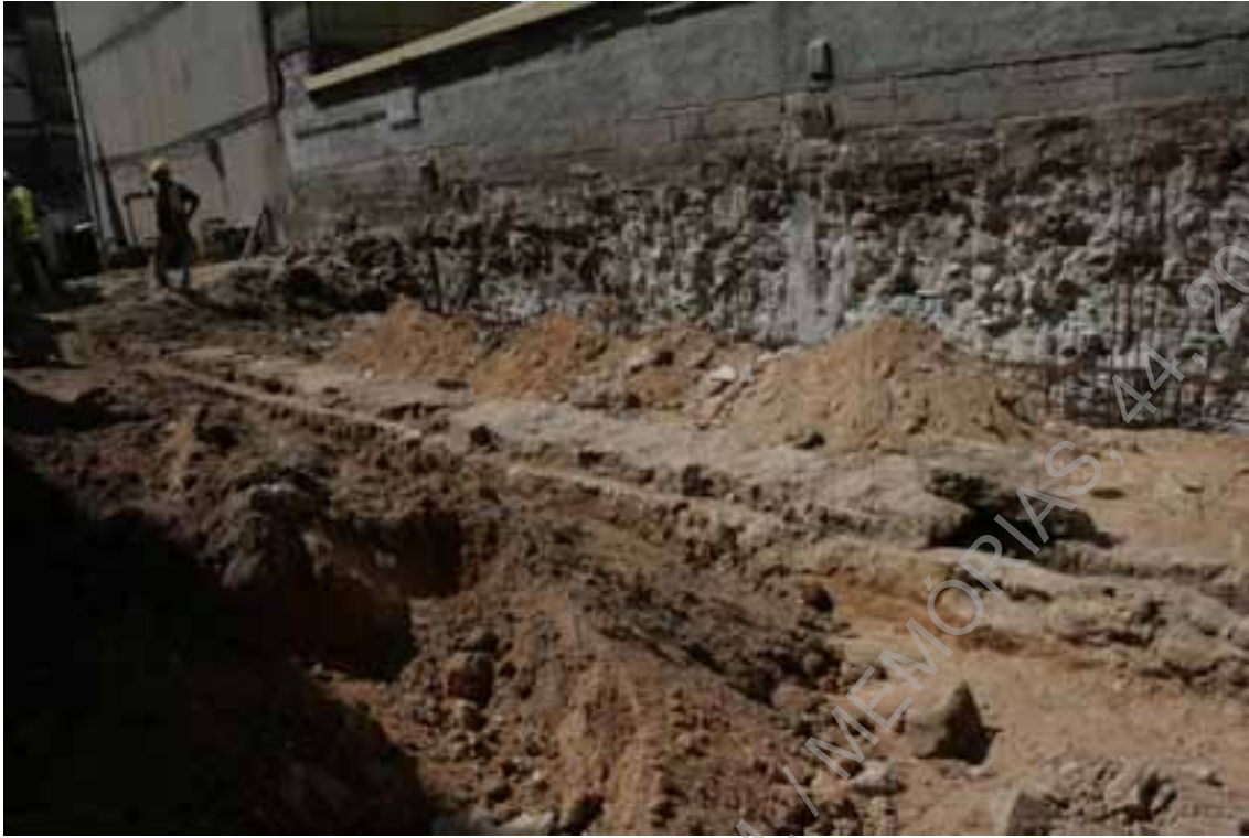
Foto 6: (UAUM – IMG_7504) Vista geral metade Este da conduta UE0001 – (SO/NE).
