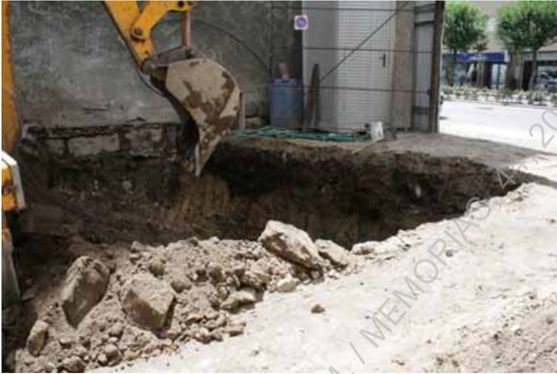
Foto 28: (UAUM – IMG_7942) Abertura de vala para fundações– (N/S).
