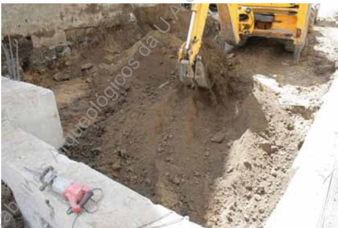
Foto 37: (UAUM – IMG_8049) Desaterro e abertura de vala – (E/O).
