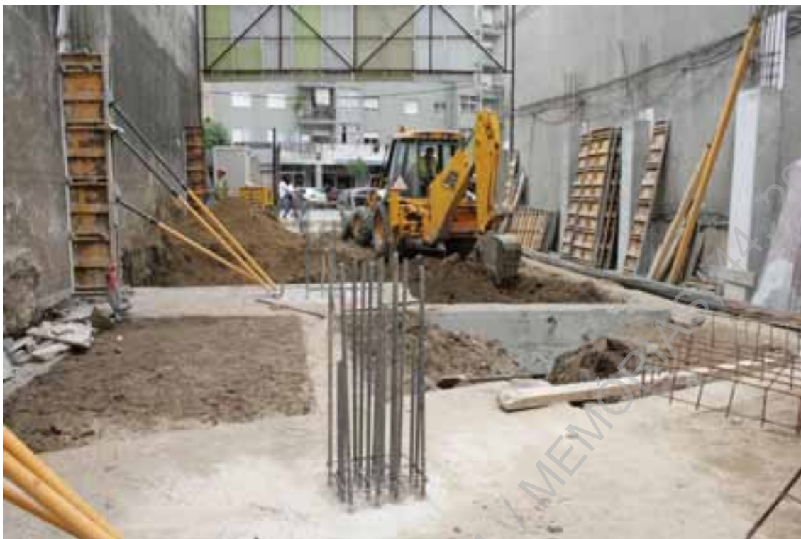
Foto 36: (UAUM – IMG_8028) Aspecto geral da obra – (E/O).
