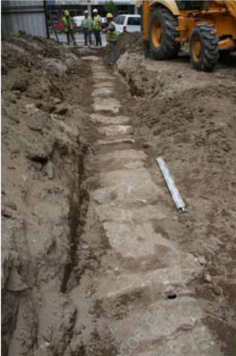
Foto 15: (UAUM – IMG_7666) Vista geral metade Oeste da conduta UE0001 – (E/O).
