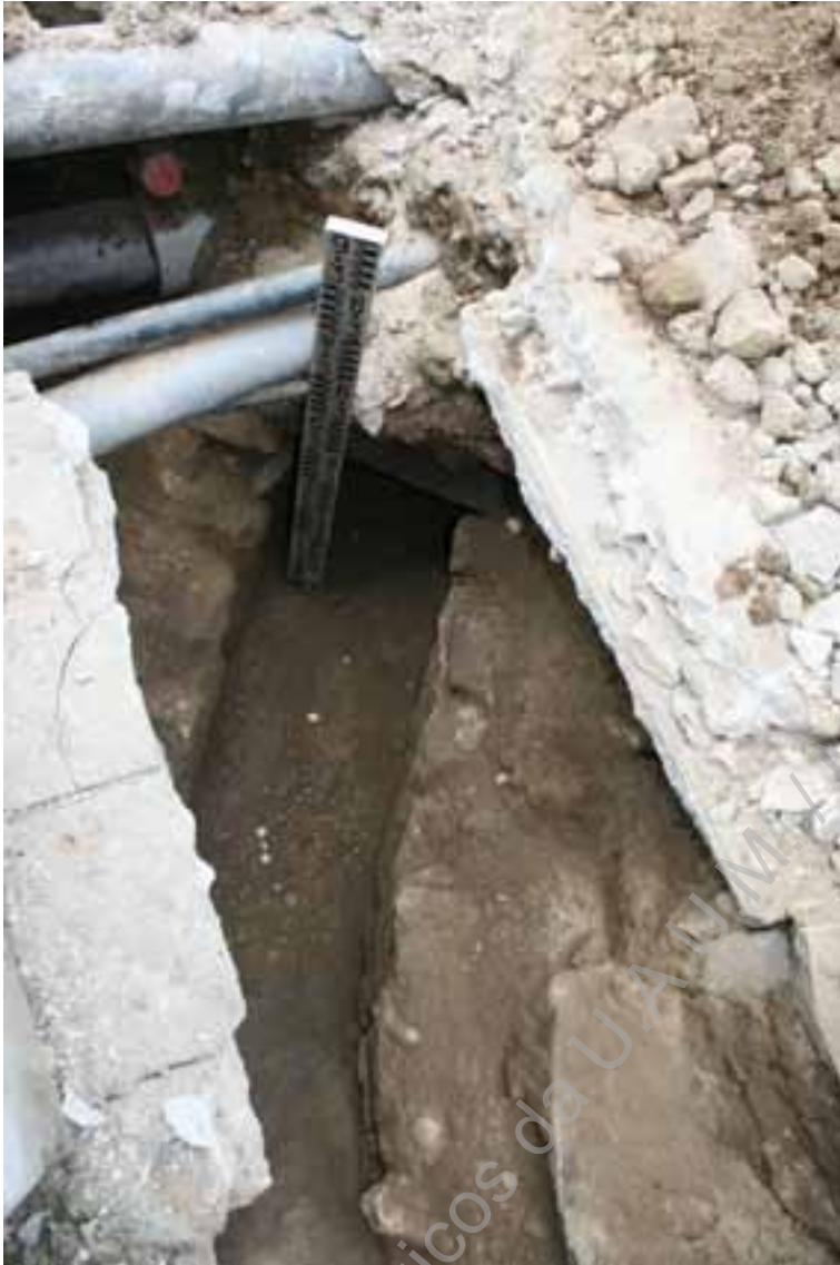
Foto 18: (UAUM – IMG_7693) Prolongamento da conduta UE0001 sob o passeio – (E/O).
