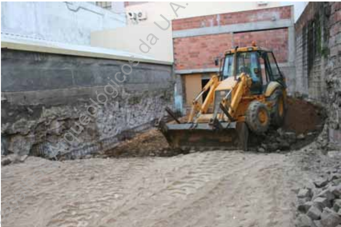
Foto 9: (UAUM – IMG_7542) Desaterro após demolição da conduta UE0001 – (O/E).
