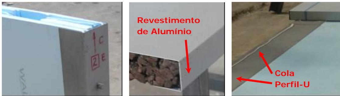
Figura 7.5 – Ligação isolamento XPS com Perfis-U em aço (esq.); revestimento em alumínio em forma de caixa com isolamento de cortiça (centro); colagem do revestimento ao perfil-U (dir.)
