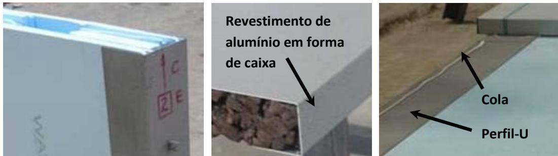
**Figura 8.10 – Interligações do módulo MRP: perfil-U com isolamento XPS (esq.); revestimento de alumínio e isolamento de aglomerado de cortiça (centro); aplicação do revestimento de alumínio (dir.)**
