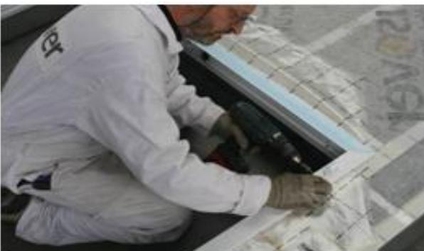
Figura 2.43 – Instalação das janelas no módulo. Fonte: IEA ECBCS Annex 50, 2011c
