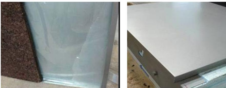
Figura 7.6 – Aplicação da barreira pára-vapor (esq.); protótipo finalizado (dir.)
