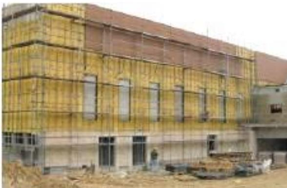
Figura 2.42 – Primeira camada de isolamento. Fonte: IEA ECBCS Annex 50, 2011c
