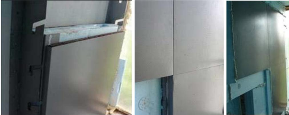
**Figura 7.8 – Colocação da estrutura de suporte, aplicação dos módulos e preenchimento com isolamento**
