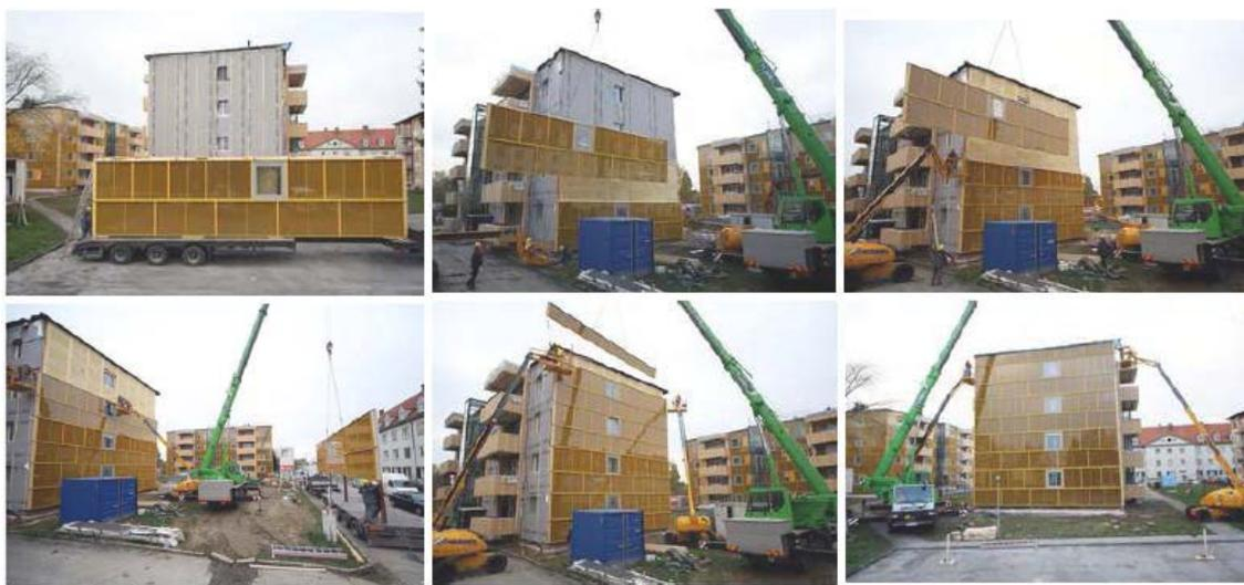
**Figura 2.37 – Transporte do módulo até ao local e montagem.** Fonte: IEA ECBCS Annex 50, 2011c
