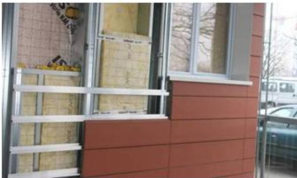
Figura 2.45 – Colocação do revestimento. Fonte: IEA ECBCS Annex 50, 2011c
