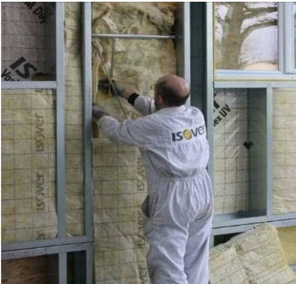
Figura 2.44 – Isolamento entre os módulos. Fonte: IEA ECBCS Annex 50, 2011c
