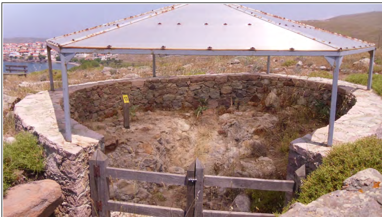
Figura 6.23 – Pormenor das estratégias de proteção física – v.g. tenda superior, cerca de madeira e muro de pedra - aplicadas ao geossítio do fóssil n.º 13 (P. de Plaka oriental) .
