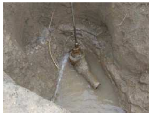
Figura 4. 1 – Vazamento de Água (Exemplos de Perdas Reais)
