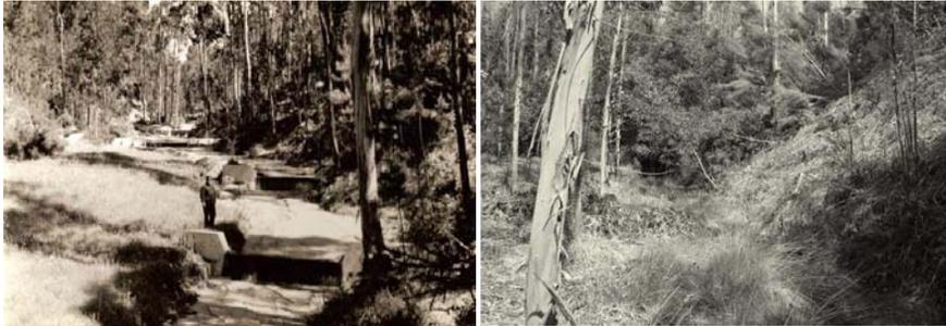
**Fotografia 5.** Obra de Correção torrencial no Rib.º Vale do Travesso, afluente do Pranto. À esquerda, uma série de barragens de alvenaria (1960). À direita, no mesmo local (2013).
