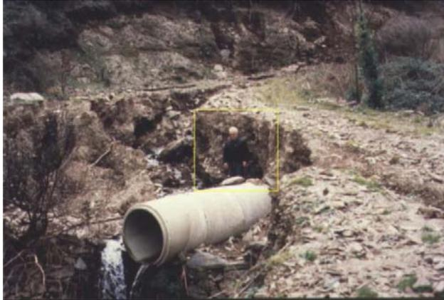
**Fotografia 11.** Pormenor da estrada que, por obstrução do aqueduto a montante, se transformou em linha de água.
