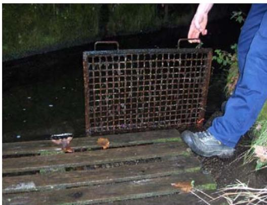
**Fotografia 3.** Pormenor de uma grelha de retenção de materiais da barragem da Senhora do Desterro.
