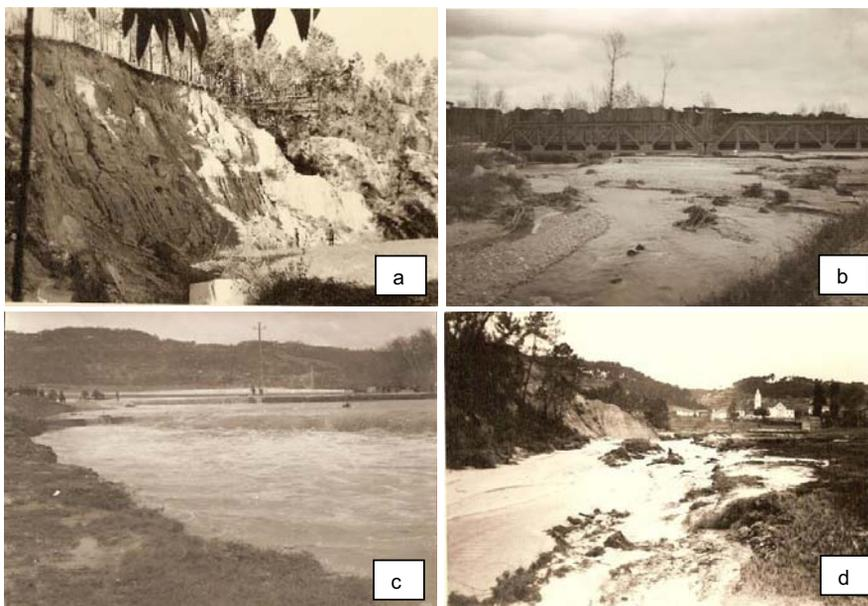
**Fotografia 2.** Impactes resultantes da erosão torrencial dos cursos de água dos rios Lis e Pranto: a) Barranco no ribeiro do Vale da Panela, afluente do Pranto (Novembro 1959); b) Assoreamento no ribeiro dos Milagres, afluente do Lis junto à ponte da via-férrea (40?); c) Cheia no rio Lis, a 20 de Fevereiro de 1966; d) Campos inundados pelo ribeiro do Vale Salgueiro, afluente do Pranto (Junho 1959)
