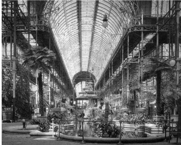
Figura 6.1 Palácio de Cristal, projetado por Joseph Paxton e construído entre 1850 e 1851. Fonte: GREVEN; BALDAUF, 2007
