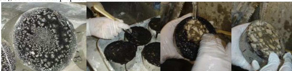
Figura 4. Processo de remoção da tinta em spray da superfície do betão com proteção permanente AGS 1
