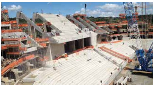
Figura 4 – (a) Vista aérea parcial da Arena. (b) Vista interna da arquibancada inferior sul e sudeste. (Arena Pernambuco – 2012)
