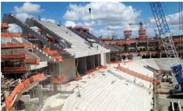
Figura 2 – Visualização da obra no setor Sul. (Arena Pernambuco - 2012)
