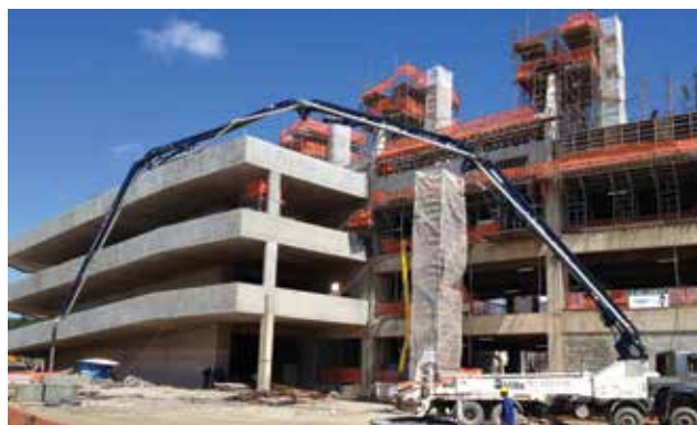
Figura 5 – Fabrico do betão
