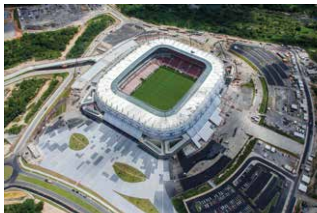
Figura 1 – Vista aérea da obra (Arena Pernambuco – 2013)
