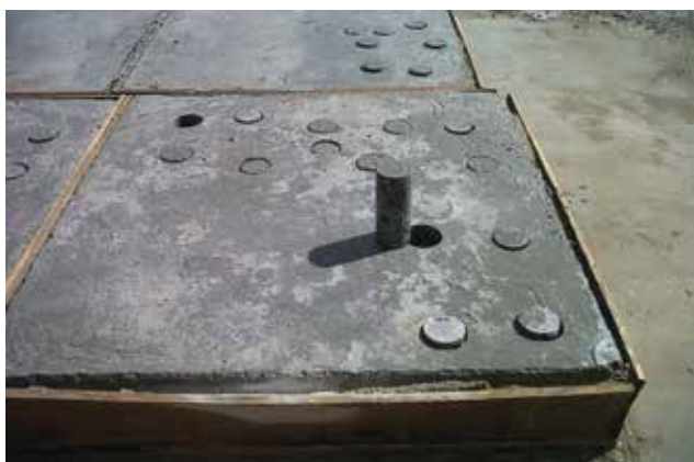
Figura 9 – Cura das carotes em condições atmosféricas do local
