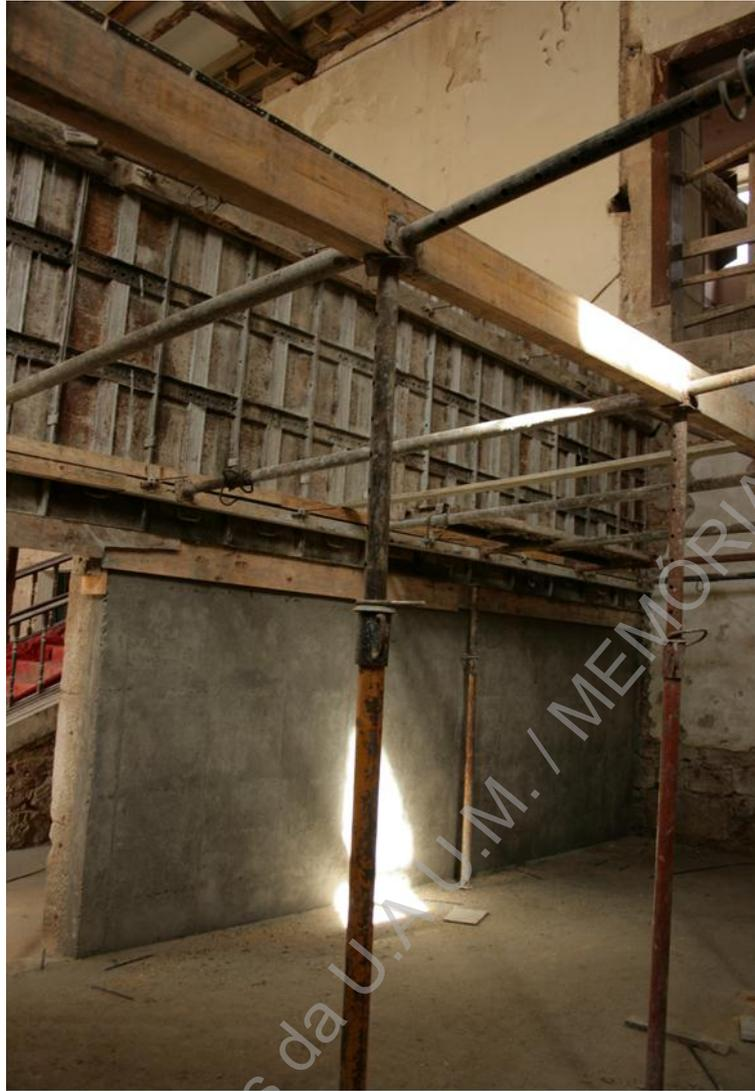
Foto 120 (D10571) – Reforço e consolidação das paredes divisórias.
