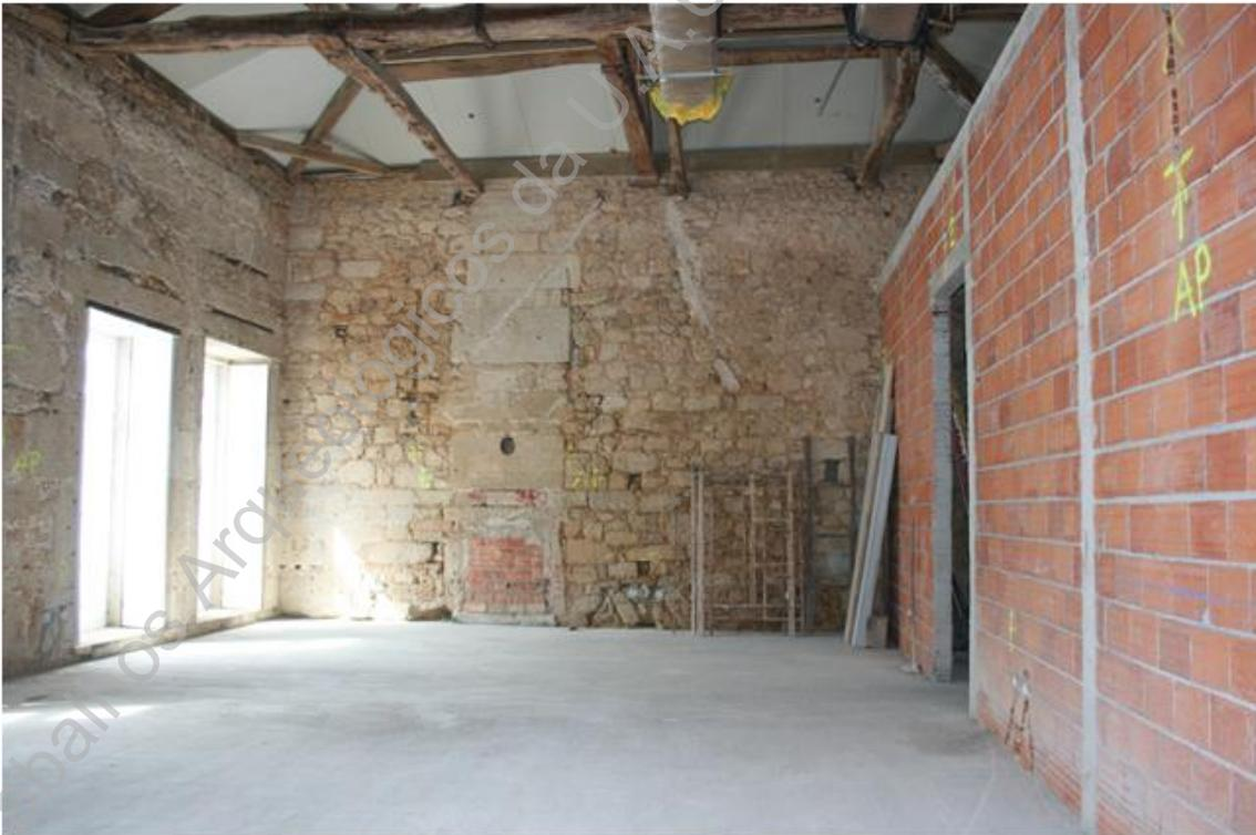
Foto 119 (D12467) – Construção da parede divisória do salão nobre da Assembleia Valenciana.
