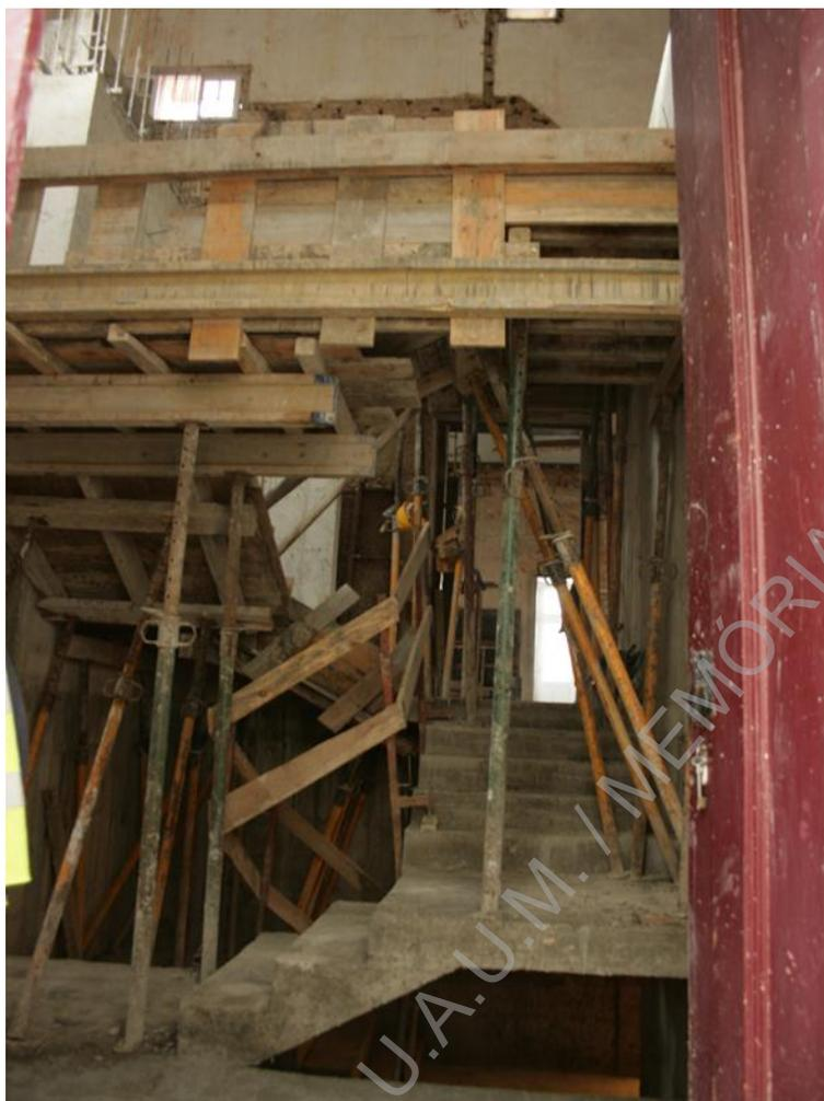
Foto 110 (D11132) – Construção das escadas de acesso aos pisos superiores.
