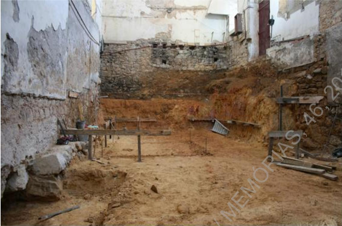
**Foto 102 (D9141)** – Marcação para construção das sapatas.
