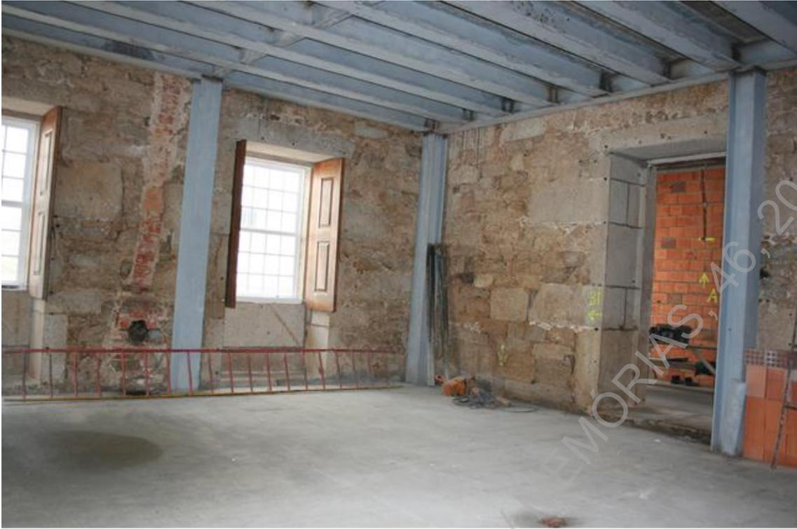
**Foto 114 (D12466)** – Colocação da estrutura para construção do segundo piso na Liga dos Combatentes.
