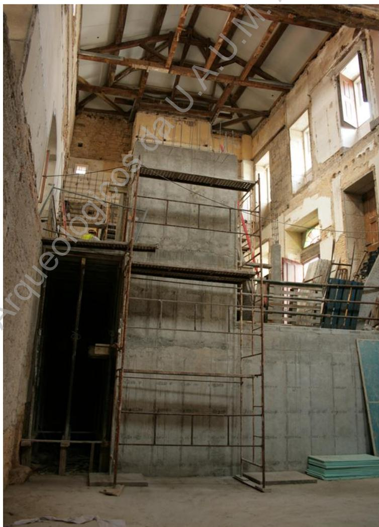
Foto 109 (D11080) – Construção da caixa do elevador.
