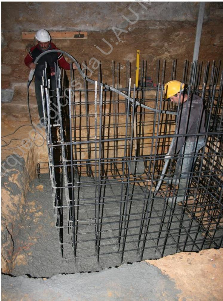
Foto 105 (D9259) – Betonagem da zona da caixa do elevador.
