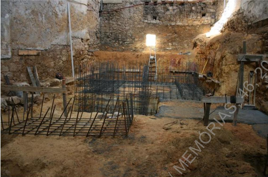
Foto 104 (D9251) – Fase de betonagem das sapatas.
