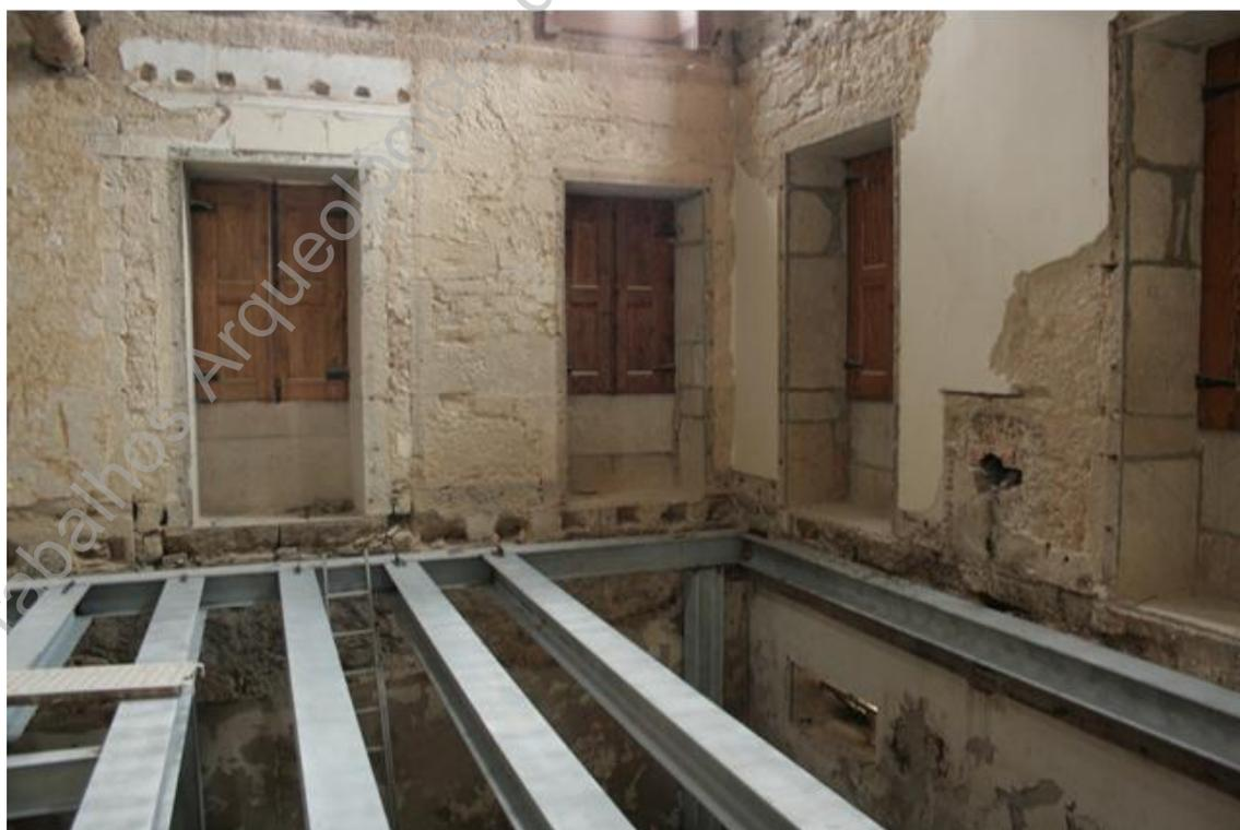
Foto 111 (D11194) – Colocação de vigas metálicas para primeiro piso na Liga dos Combatentes.
