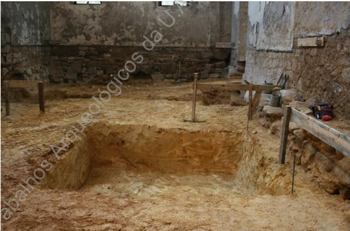
**Foto 103 (D9151)** – Escavação para implantação das sapatas.
