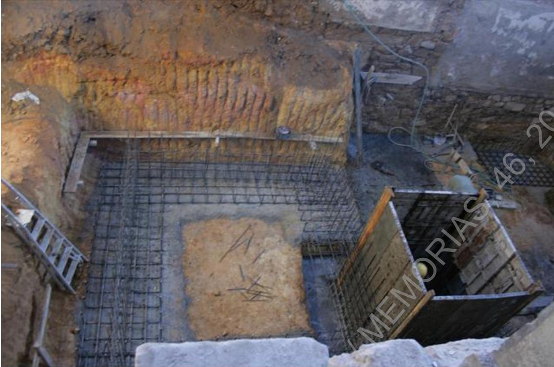
**Foto 106 (D9283)** – Aspeto da betonagem das fundações.
