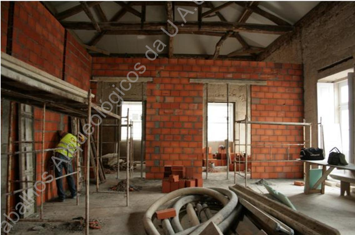
**Foto 122 (D11135)** – Construção das paredes divisórias na Assembleia Valenciana.
