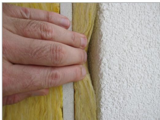
Figura 15 – Pormenor do isolamento dúctil junto à parede existente (M. Zimmermann, 2011; P. Schwehr, R. Fischer, S. Geier, 2011; R. L. Kobler et al, 2011)
