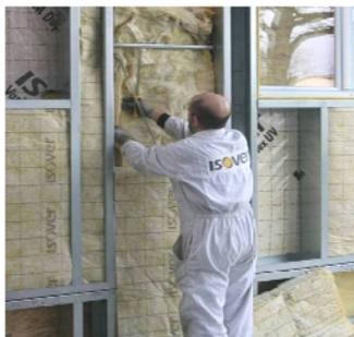
Figura 30 – Isolamento entre os módulos (M. Zimmermann, 2011; P. Schwehr, R. Fischer, S. Geier, 2011; R. L. Kobler et al, 2011)
