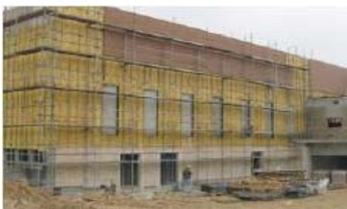
Figura 28 – Primeira camada de isolamento (M. Zimmermann, 2011; P. Schwehr, R. Fischer, S. Geier, 2011; R. L. Kobler et al, 2011)
