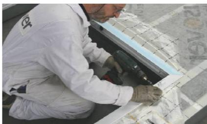
Figura 29 – Instalação das janelas no módulo (M. Zimmermann, 2011; P. Schwehr, R. Fischer, S. Geier, 2011; R. L. Kobler et al, 2011)
