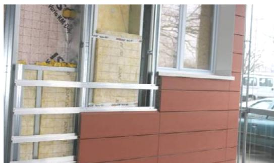
Figura 31 – Colocação do revestimento (M. Zimmermann, 2011; P. Schwehr, R. Fischer, S. Geier, 2011; R. L. Kobler et al, 2011)
