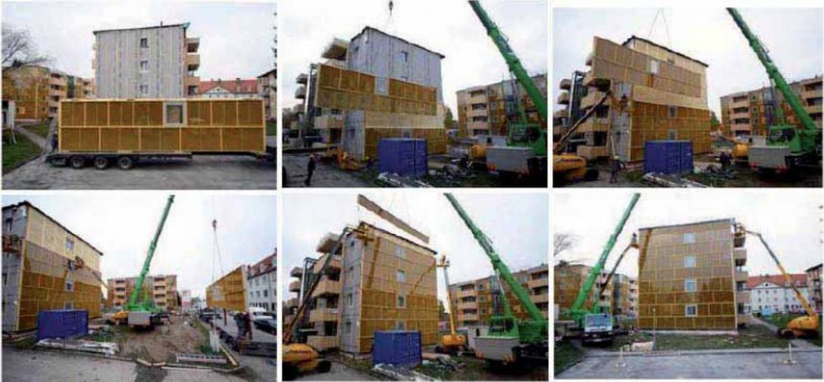
Figura 20 – Transporte do módulo até ao local e montagem (M. Zimmermann, 2011; P. Schwehr, R. Fischer, S. Geier, 2011; R. L. Kobler et al, 2011)
